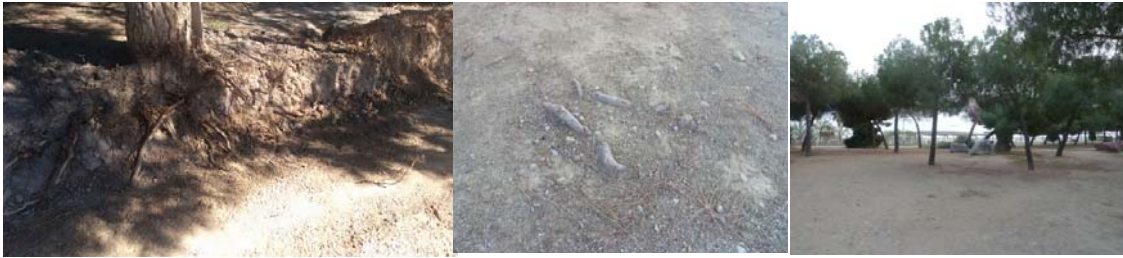
Arrels superficials a respectar, pujant base del paviment de grava per evitar possibles patologies
