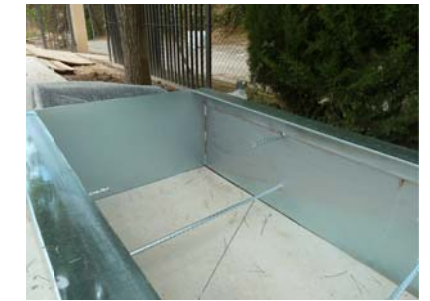
Acabat soldadura llisa i continua
