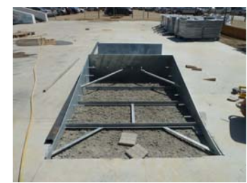
Detall Tipus d'ancoratges i riostres
