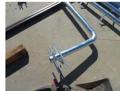
Detall Tipus d'Ancoratges de Rail
