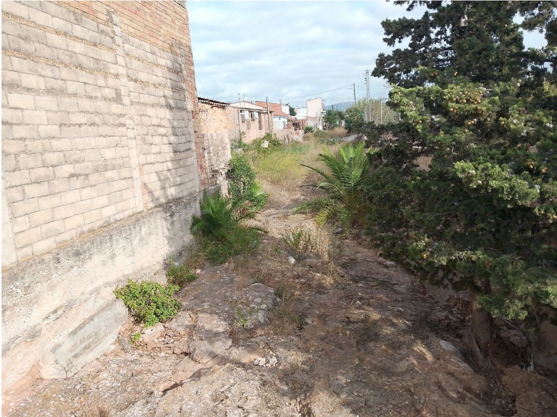
Fotografia 7. Vista des del pont de l'Avda. Conseller J. Navarro
