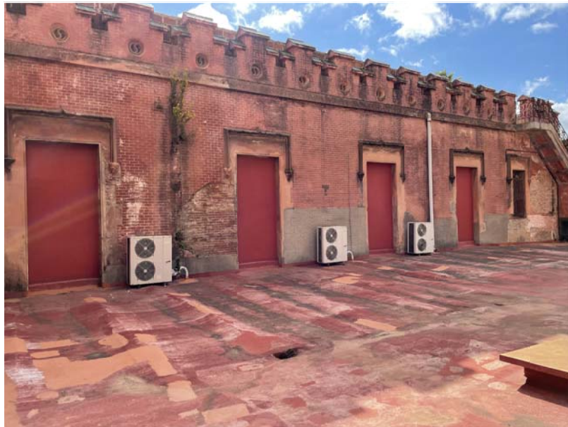
1. Façana cambra agària des de la terrassa
