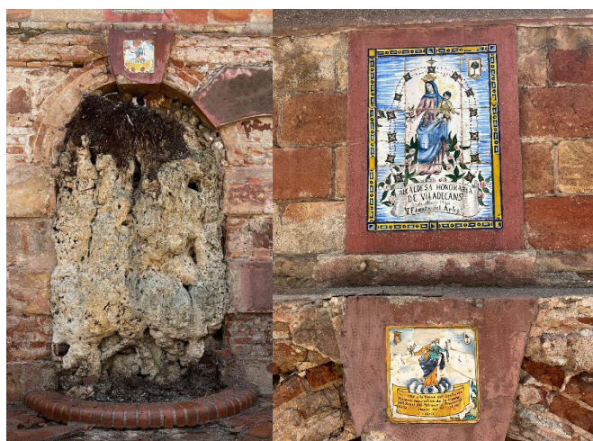
Fig. 26. Procés de restauració finalitzat.
