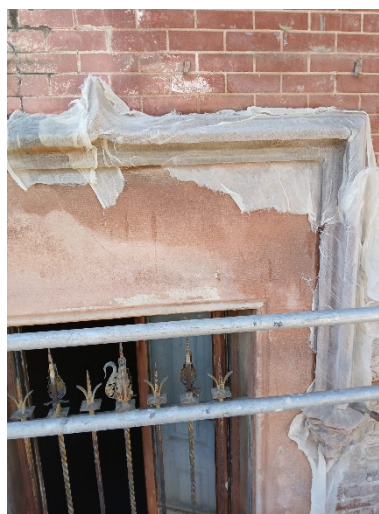
Fig. 21 i 22. A l'esquerra procés d'allargament de l'arc conopial, a la dreta durant el procés d'arrancament de l'arc.
