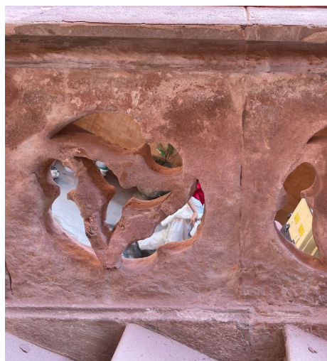
Fig. 5 i 6 Degradació greu del suport i pèrdua matèrica abundant dels volums de pedra.
