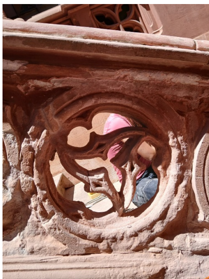
Fig. 1 i 2. Elements ornamentals de la balustrada que pertany a l'escalinata. Estat de conservació molt deteriorat per l'efecte de les filtracions d'aigua i la posterior aparició de sals solubles que dissolen el suport petri.
