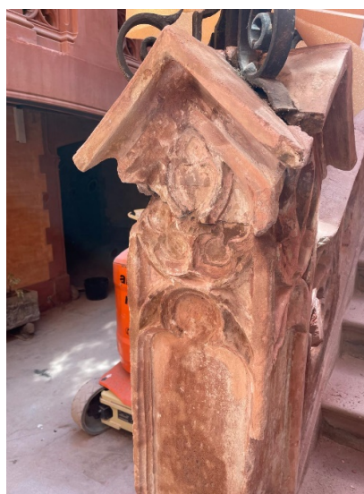
Fig. 1 i 2. Elements ornamentals de la balustrada que pertany a l'escalinata. Estat de conservació molt deteriorat per l'efecte de les filtracions d'aigua i la posterior aparició de sals solubles que dissolen el suport petri.
