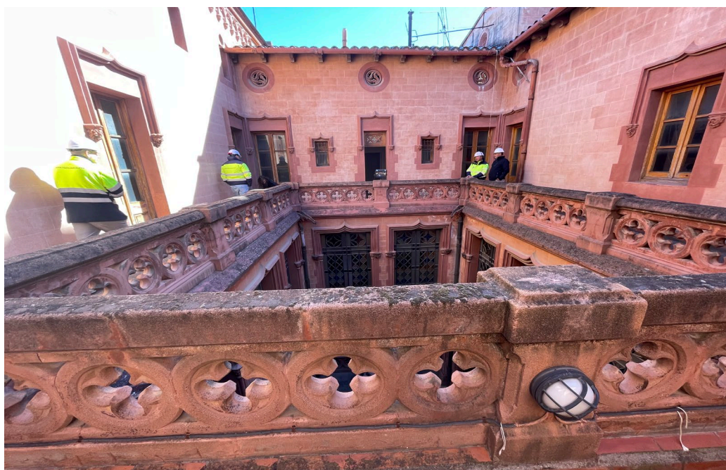
Fig. 7 Balustrada superior amb patina biològica que ennegreix el cromatisme original.
