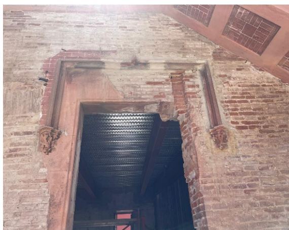
Fig. 21 i 22. A l'esquerra procés d'allargament de l'arc conopial, a la dreta durant el procés d'arrancament de l'arc.
