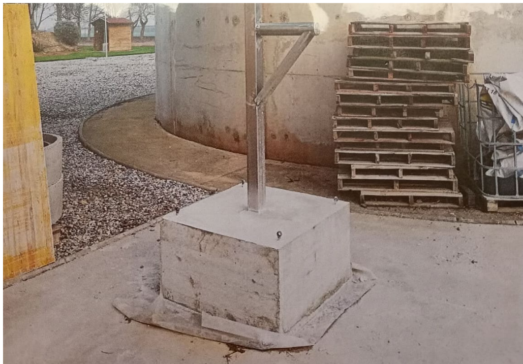
Pedestal fixació agitador
