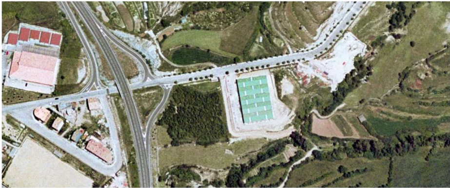
Imatge aèria posterior a la construcció de la nau (2001)
