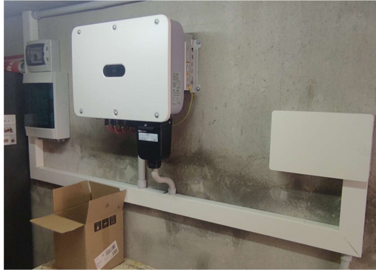
Imatge inversor i proteccions
