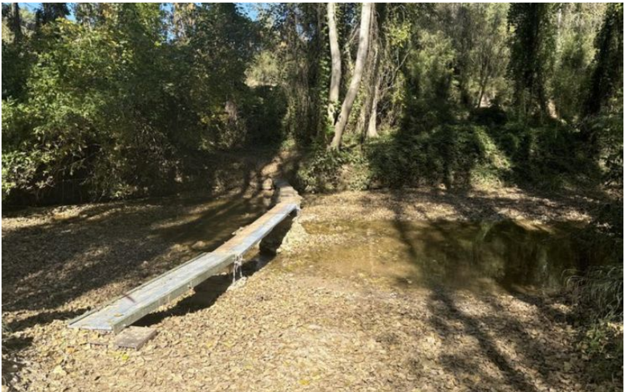
Palanca o pas de taulons de sota de cal Riera abans de la riuada.
