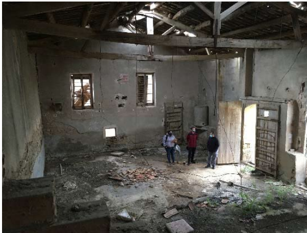
Interior del cos est
