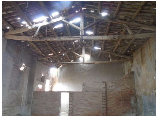
Interior del cos est
