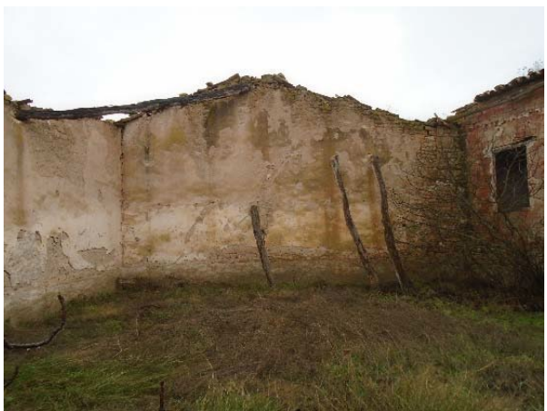
Interior del cos oest
