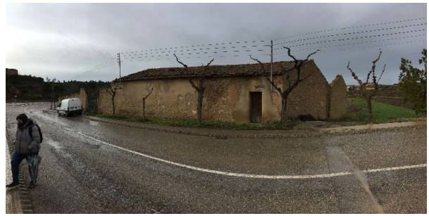
Imatge façana Lateral
