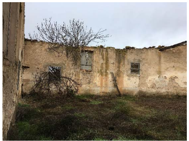
Interior del cos oest
