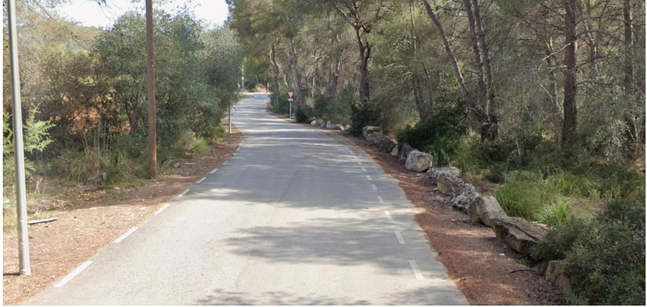
Il·lustració 5: Secció actual del tram en estudi, de calçada única de sentit bidireccional. No hi ha itinerari de vianants delimitat, el voral no és continu al llarg de tot el tram. Font Google Maps.
