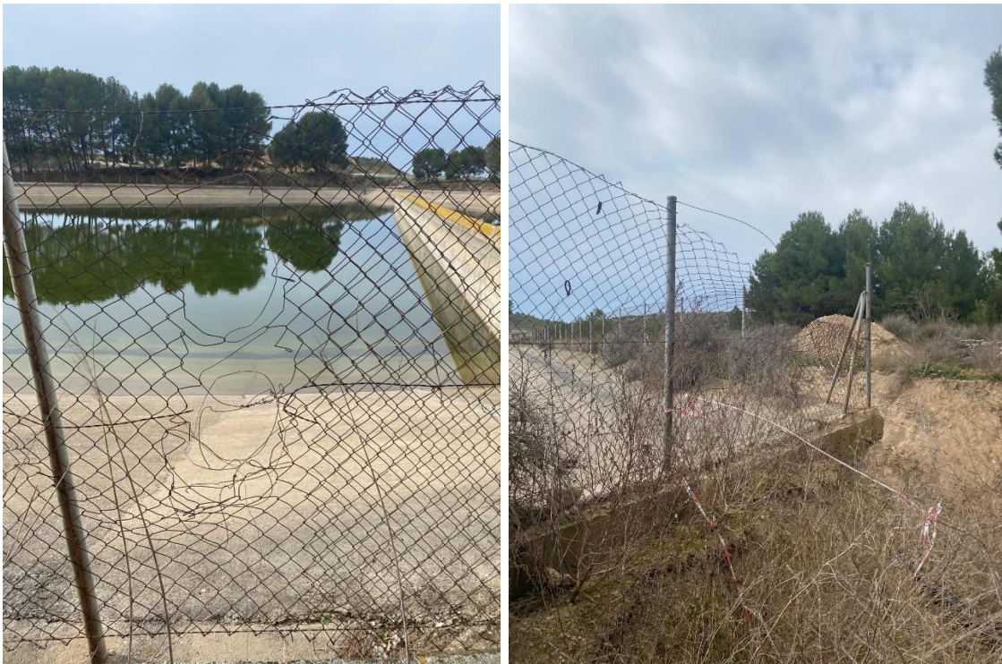
Tanca perimetral de la bassa
