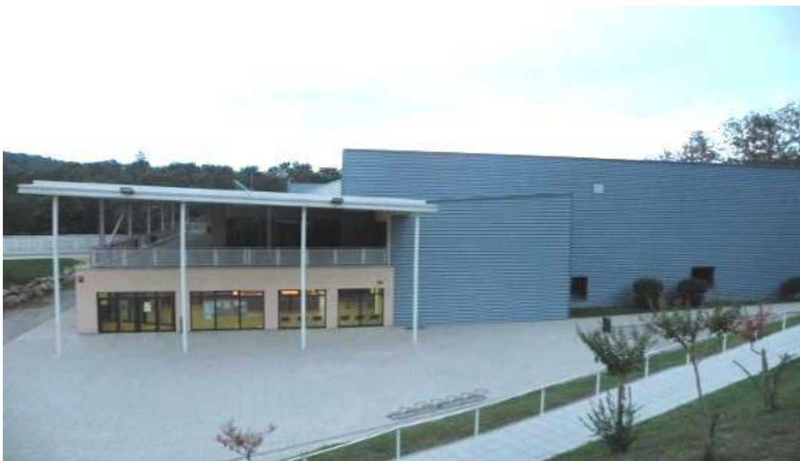
Imatge del pavelló poliesportiu de Can Pons.
