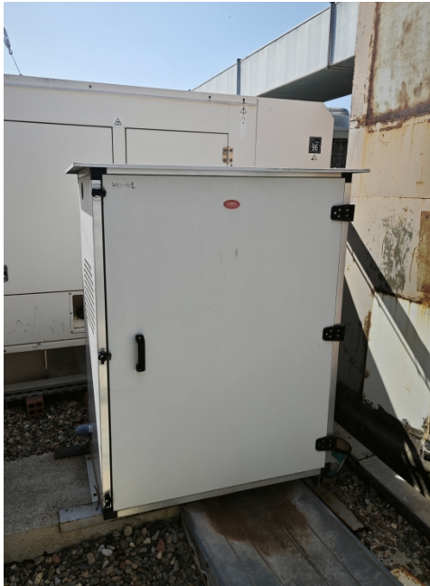
Imatge de l'accés a la coberta:
