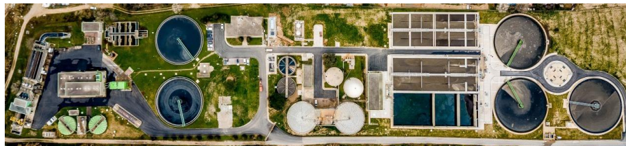
Vista aèria de l'EDAR La Llagosta
