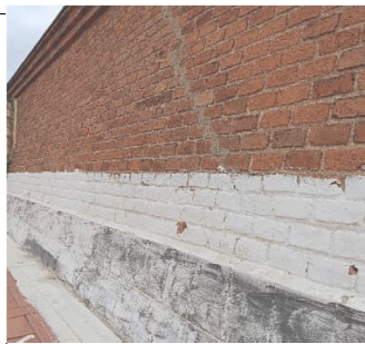
Fissura transversal en el mur
