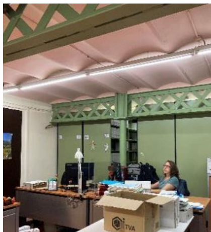
Biguetes metàl·liques sobre jàsseres
