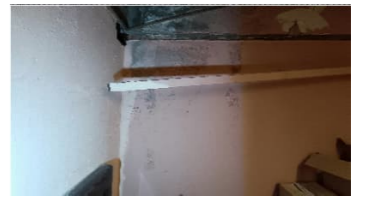
Tensors horitzontals trencats, oxidats i destensats
