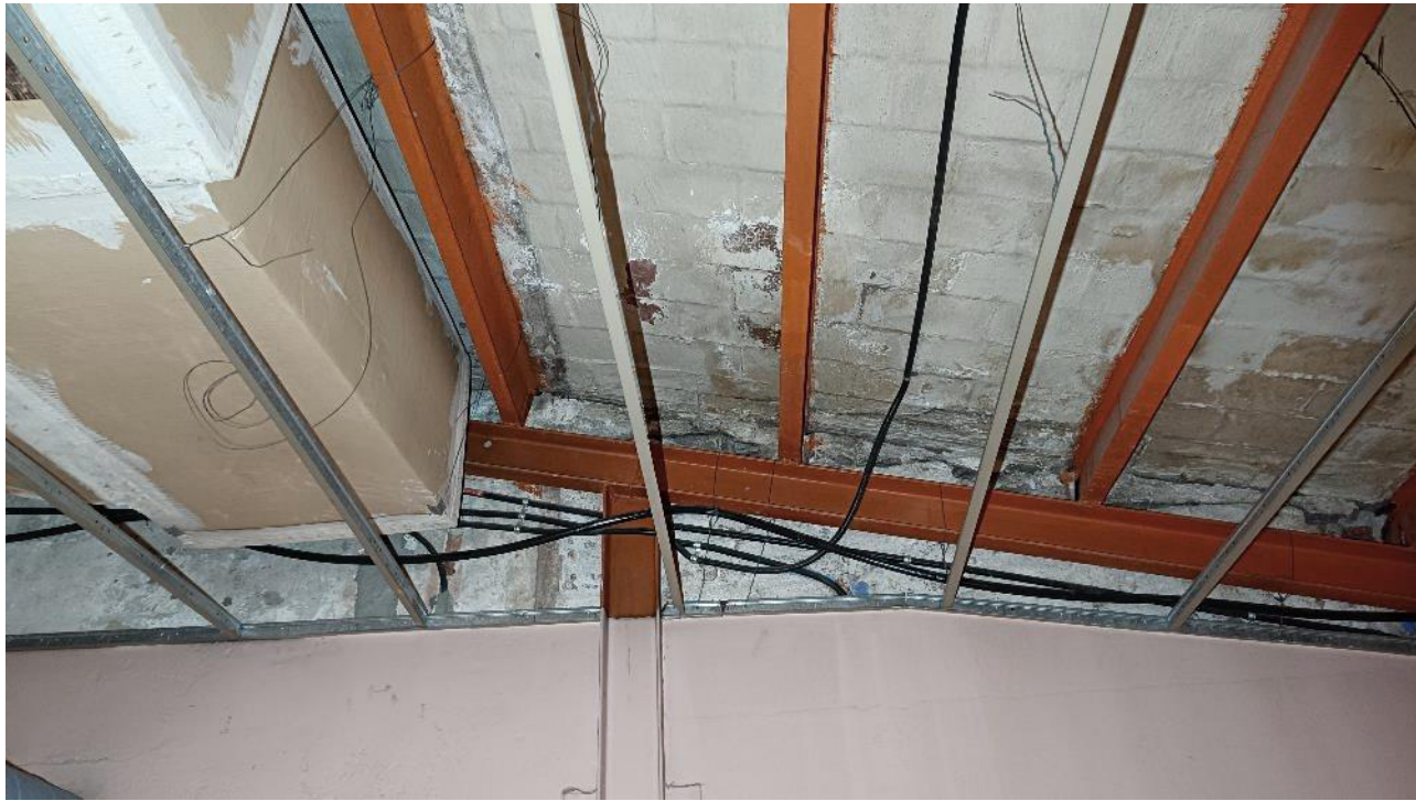
Les diverses taques en la rajola ceràmica ocasionada per la infiltració d'aigua són evidents. També s'observen peces de rajola trencades i esquerdes en murs. Així com caps de bigues oxidades, generalment en àmbits on s'observen les escorrenties.
