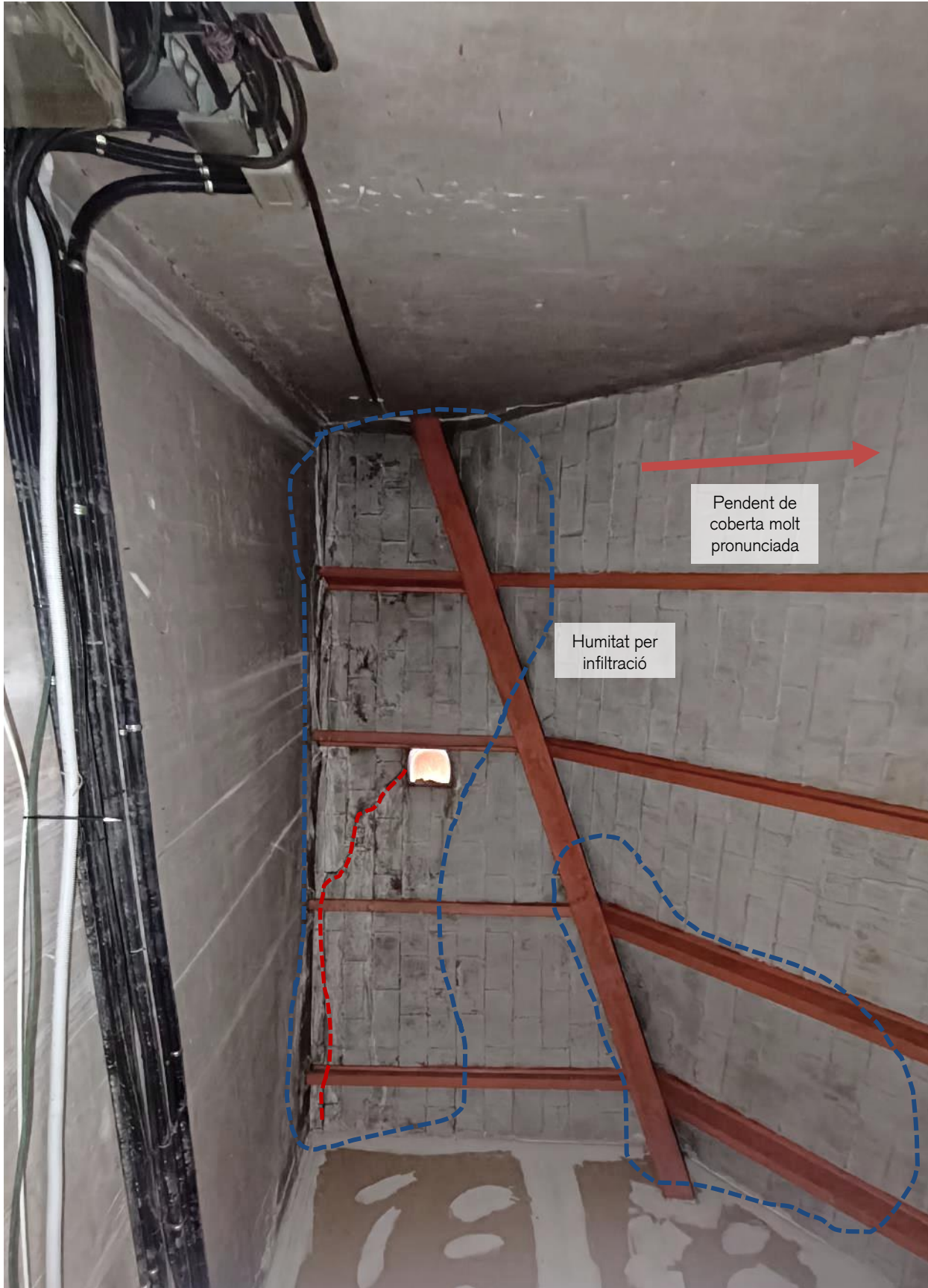
S'observen les fissures i esquerdes, i les taques de filtracions d'aigua.
