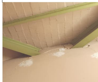
Trobada entre bigues en cantonada superior de coberta
