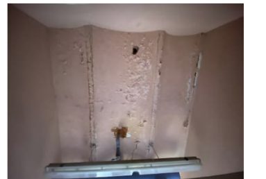
Trencaments de revoltons ceràmics Fuites a la instal·lació de fontaneria
