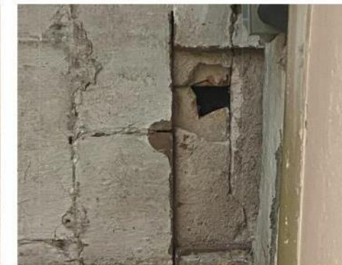
3 - Imatge / cala 3: s'observa dos capes de rajola ceràmica amb manca de tela impermeable
