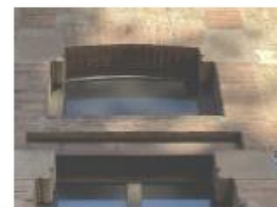
Obertures compostives de façana coronades amb dentells metàl·lics i ceràmics.
