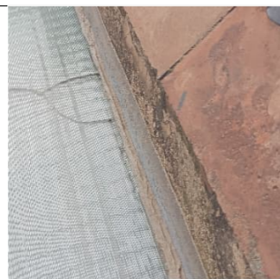
Trencament de claraboia
