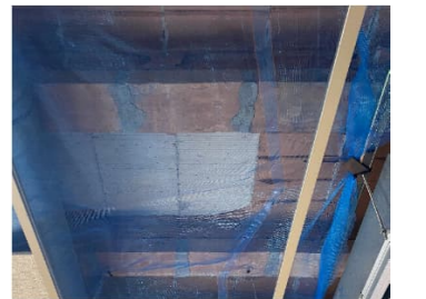
Trencaments de revoltons ceràmics Fuites a la instal·lació de fontaneria
