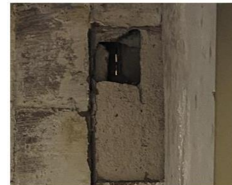
2 - Imatge / cala 2: s'observa dos capes de rajola ceràmica amb manca de tela impermeable
