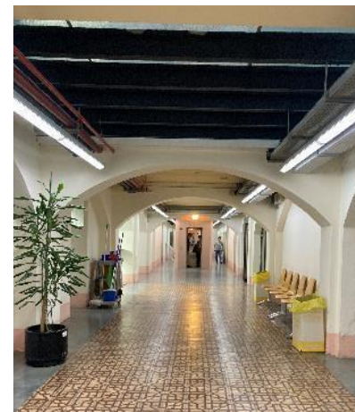
Biguetes metàl·liques recolzades sobre arcs.
