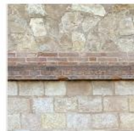
Sòcol de carreus de pedra regulars a trencajunts rematats amb una filera de maó ceràmic
