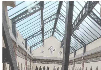
Estructura metàl·lica de claraboia vista des de l'interior
