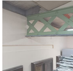
Biga IPN adossada en mur de façana per a reforçar les obertures de finestra
