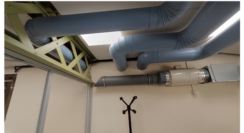
Pèrdua de temperatura per grans recorreguts de les canelles d'aigua i aire. Impulsió i retorn. S'observa instal·lacions desconnectades i sense ús.
