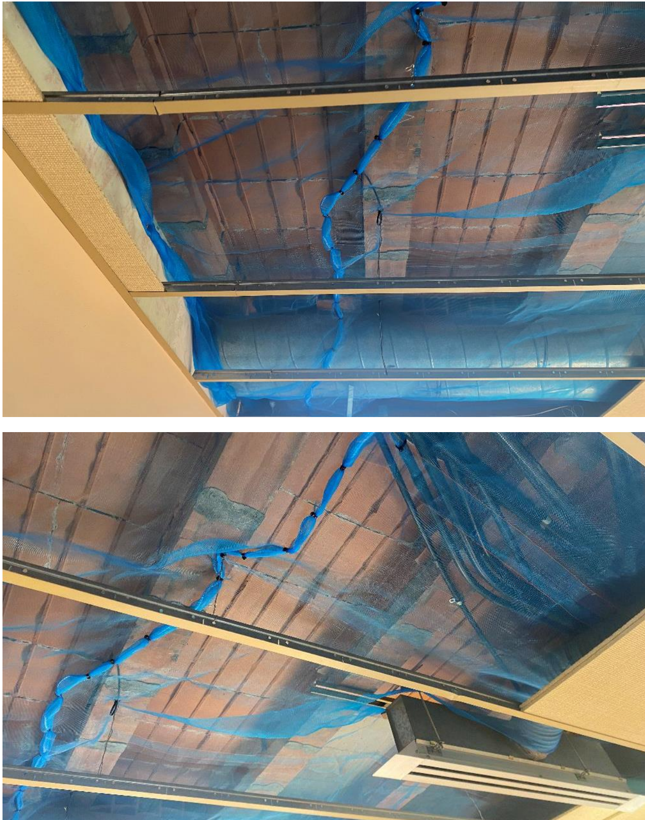
S'observa a les imatges una xarxa de protecció pels trencament dels revoltons ceràmics dels altells degut a una diferència de dilatació entre materials.
