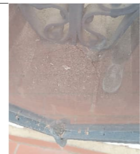
Fissures en l'obertura per la col·locació de les reixes
