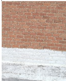
Mur impermeabilitzat en la base per humitat
