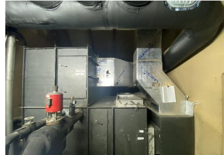
Imatge d'unitat de tractament d'aire
