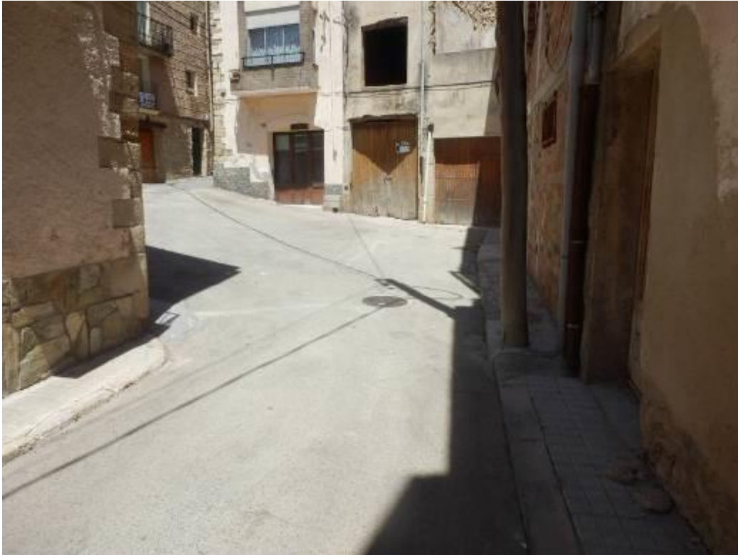
F01. Vista general de la plaça de Sant Joan des del carrer de Sant Joan.
