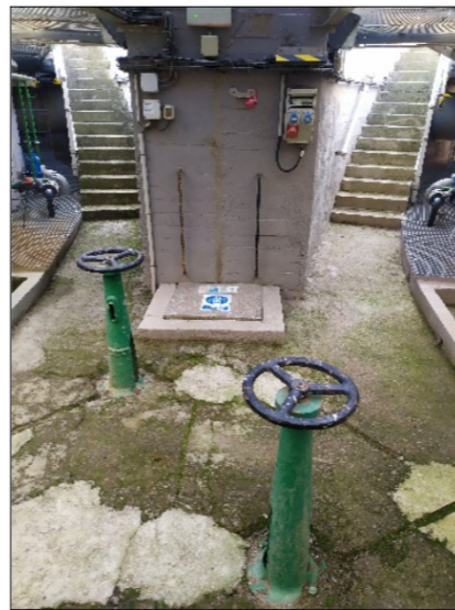
ARQUETA DOBLE VÁLVULES DESGUÀS DECANTADOR Nº 5-6
