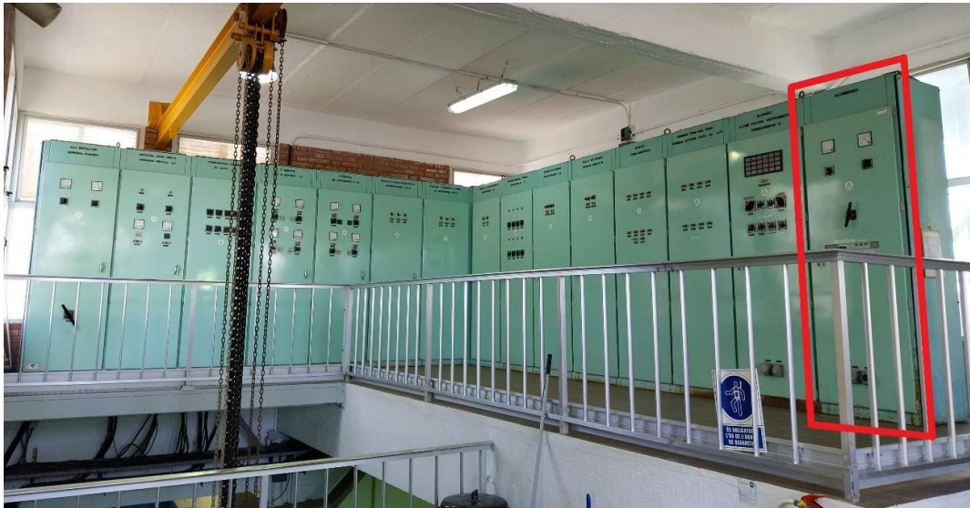
Fig. 5. Armari CCM Control i Mesura
