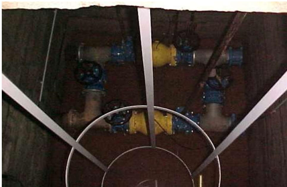
Fig 3: Detall disposició de vàlvules manuals 1 vàlvula amb extensió d'eix 2 vàlvula amb volant
