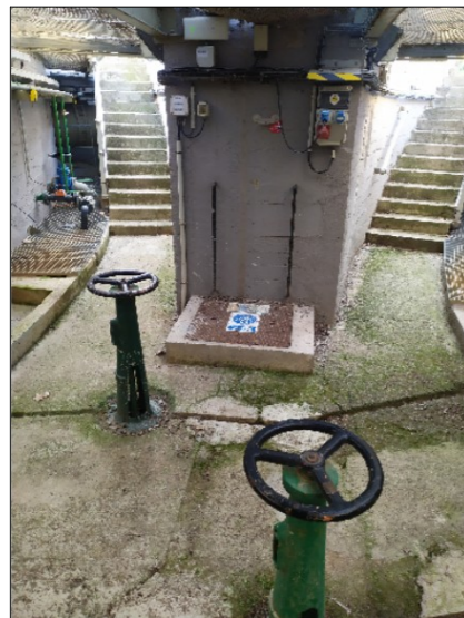
ARQUETA DOBLE VÁLVULES DESGUÀS DECANTADOR Nº 1-2
