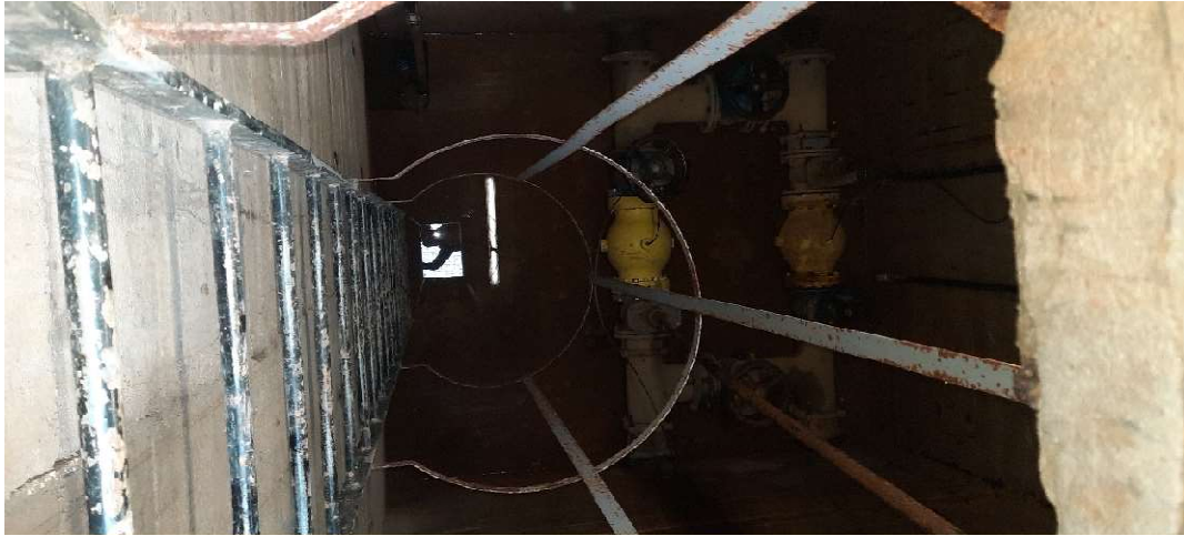
Fig 1: Instal·lació de vàlvules de purga
