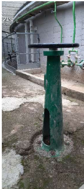
Fig 2: Volant d'apertura de vàlvula manual a l'exterior de l'arqueta
