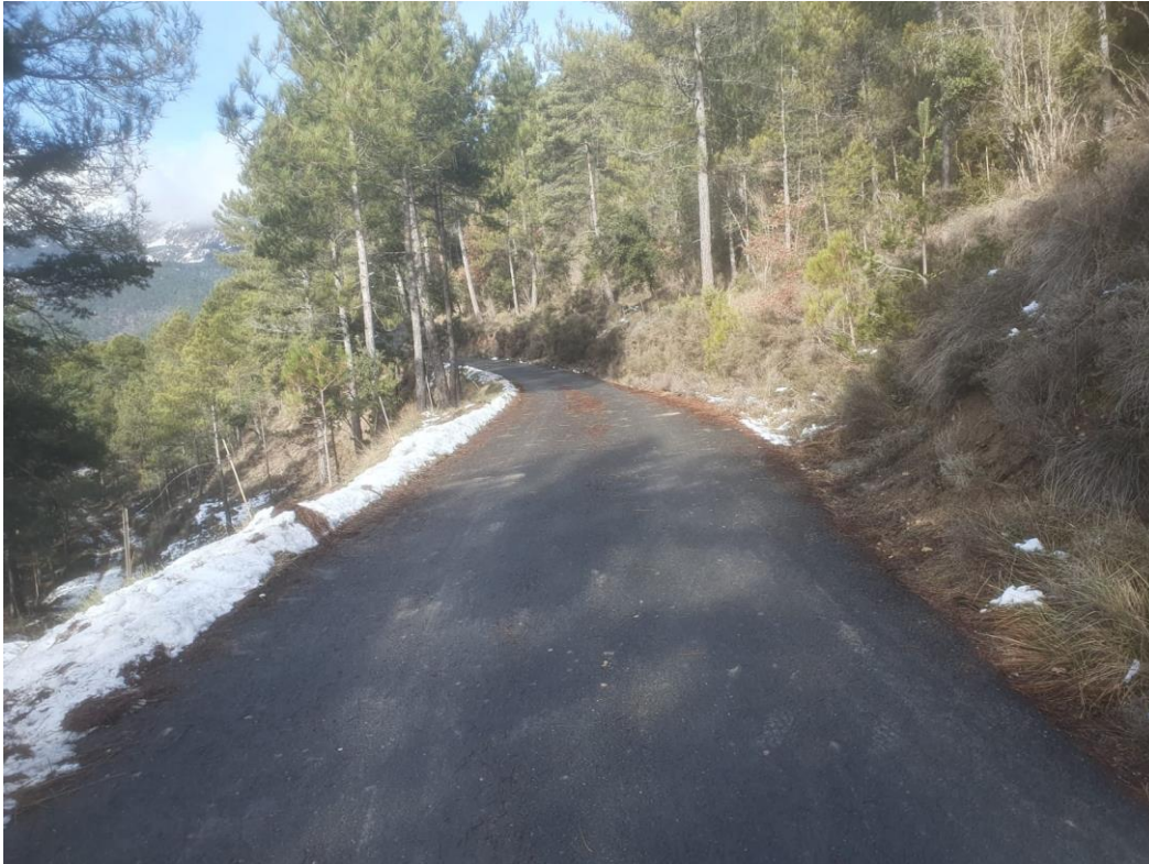
Cunetes de formigó
