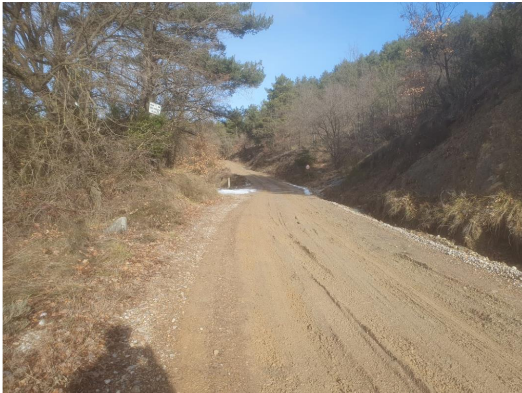
Cunetes de formigó
