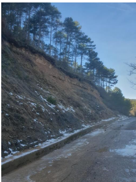
Imatge talús núm 2, amb el mur a la base i malla preexistent
