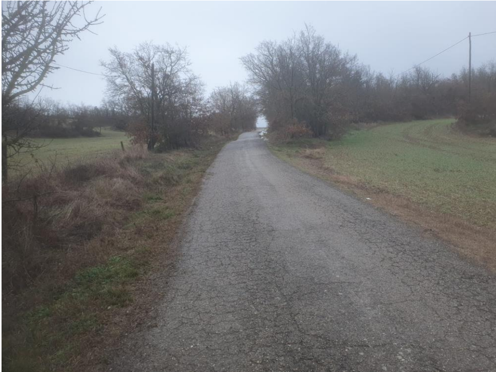
Cuneta i asfalt MBC - tram 1-2
