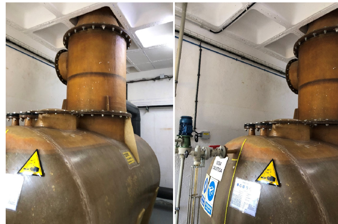
Figura 6. Vista dipòsit sosa càustica existent
