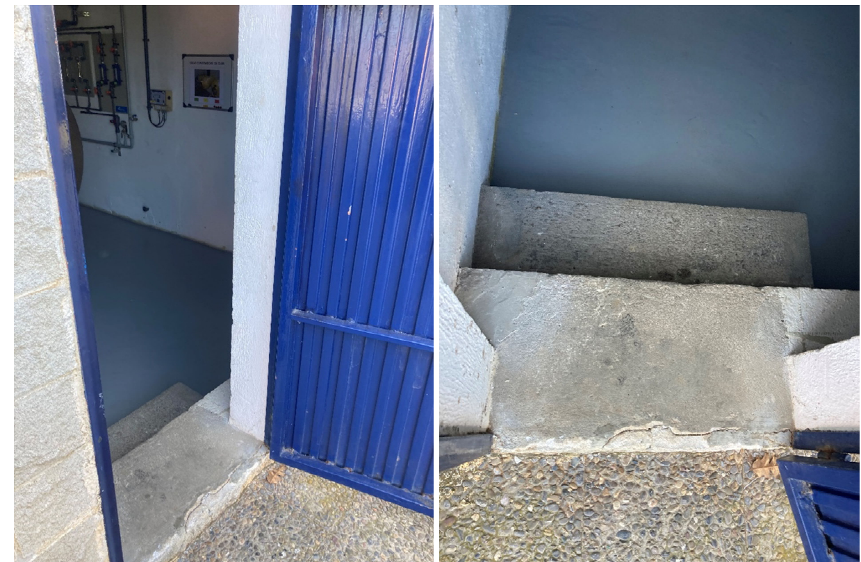
Figura 2. Vista accés sala dipòsit sosa càustica des d'exterior
