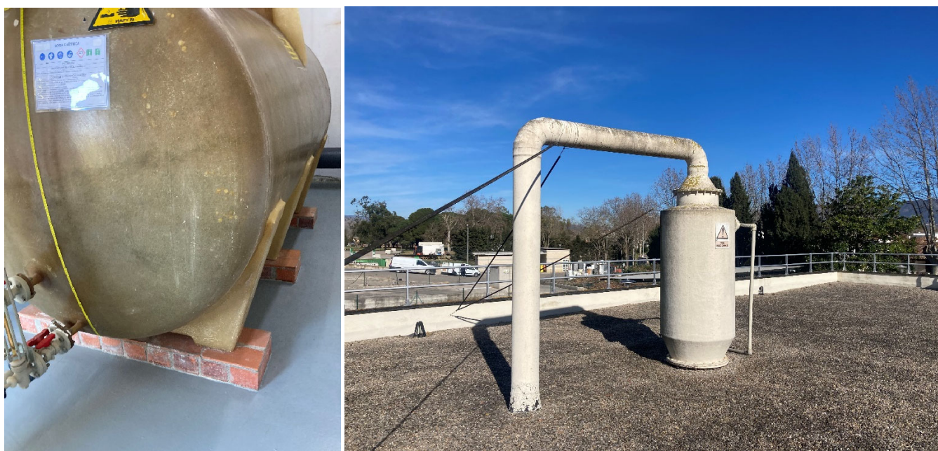
Figura 11. Suports dipòsit sosa càustica i torre neutralització i conductes exteriors coberta
