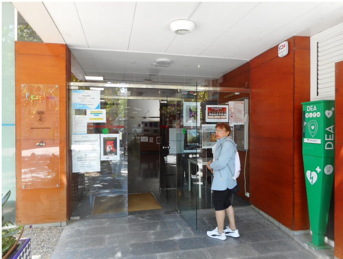
Figura 1- Accés principal a la llar d'avis, pel carrer Comissió de festes. Vista exterior. S'accedeix per mitjà de doble porta batent cap a l'exterior, amb un espai intermig, i altre cop doble porta batent cap a l'exterior.
