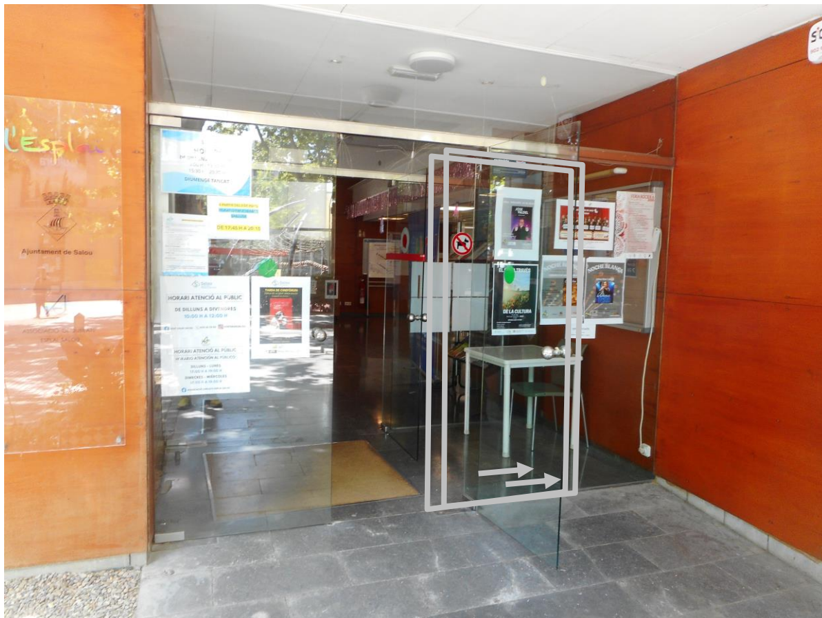
Figura 5- Aproximació visual del sistema de porta doble corredissa telescòpica.
