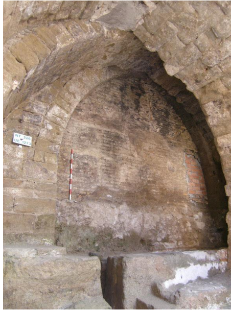
Foto 5: Vista general de les voltes de l'adobaria núm. 5 que suporten el carrer Blanquers. Al fons arc apuntat i tapiat que es comunica amb el gran celler conservat sota la casa del número 7 del carrer Blanquers i a través del qual s'accedia a l'adobaria construïda a cel obert i tancada per la muralla o límit fluvial de la ciutat.
