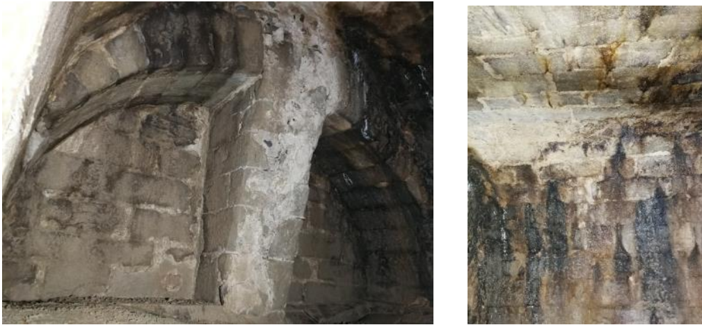
Figura 17: A la dreta, el tancament nord de la volta amb l'arc i el contrafort de reforç que suporta la mitgera de les cases que hi ha a sobre -façana nord del carrer Blanquers núm. 7).
