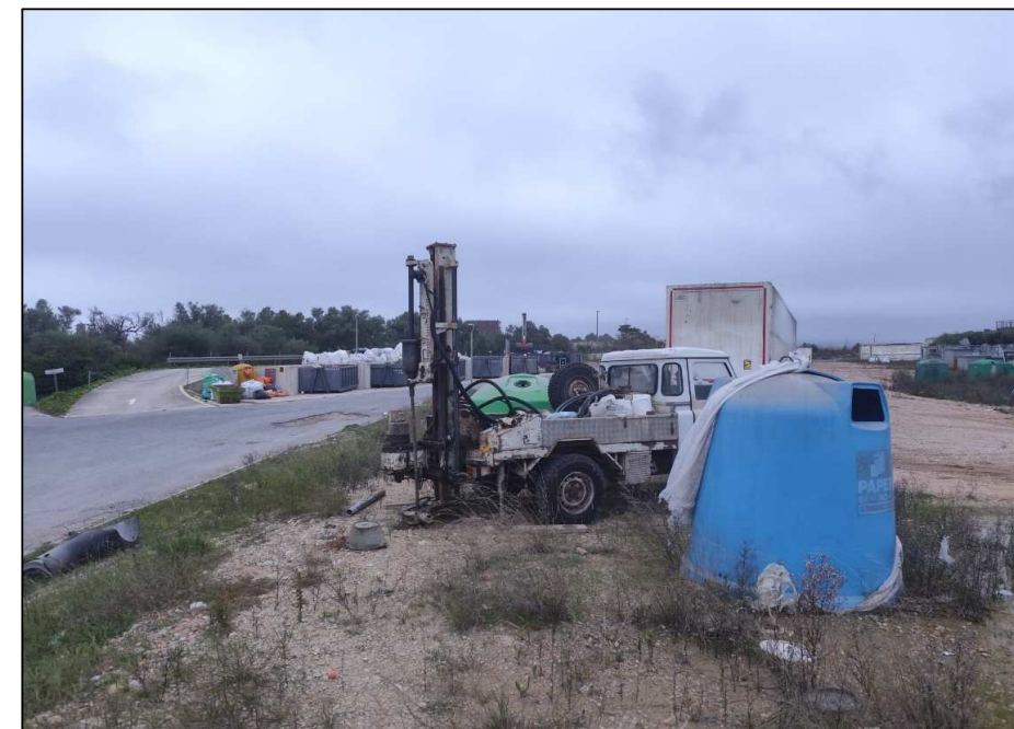
Emplaçament del penetròmetre P-2.
