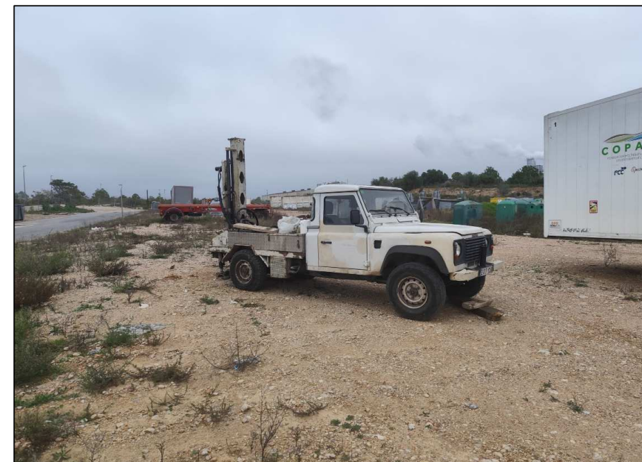
Emplaçament del penetròmetre P-1.
