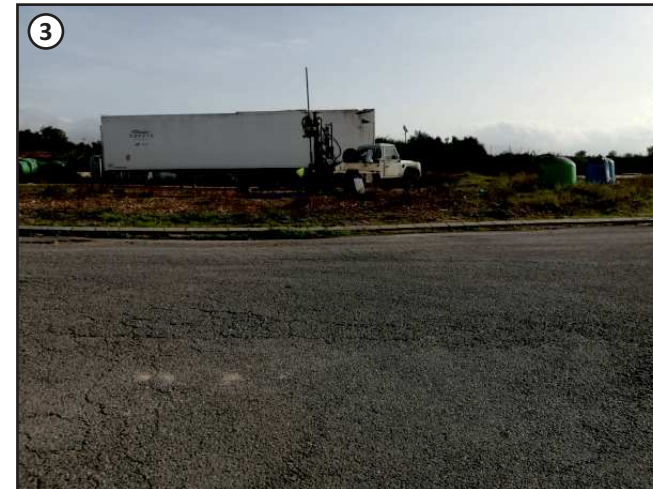
3 Vista general de la zona d'actuació des del camí d'accés a la deixalleria.
