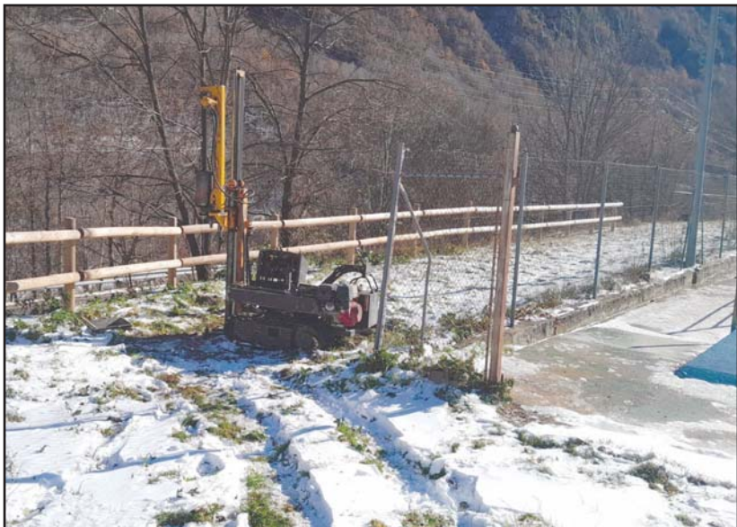
Fotografia 1. Vista de l'emplaçament de la màquina per a la realització del sondeig a rotació amb bateria continua S-1.
