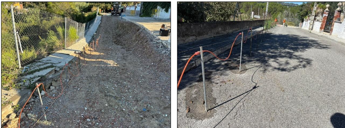
Imatge 2-1. Muntatge dels perfils de tomografia.
