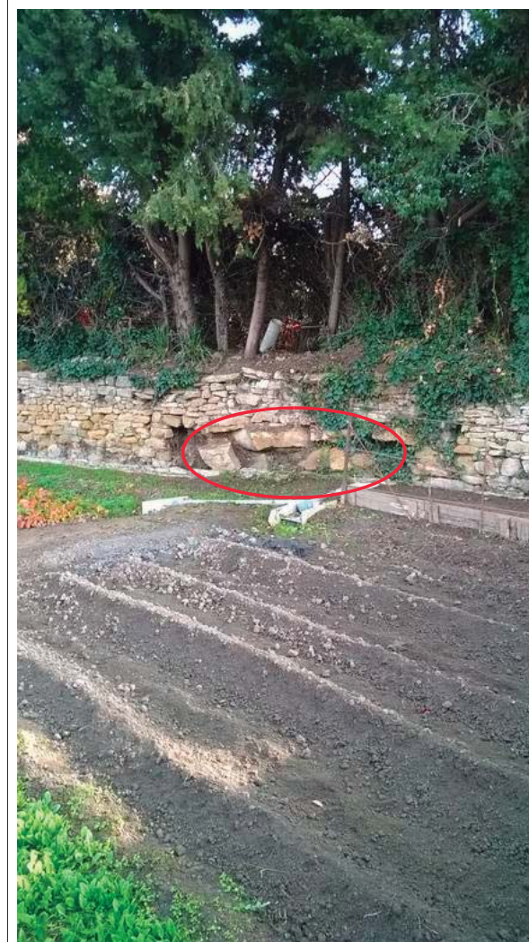
Vistes dels materials rocosos del subòl de la zona aflorant en un tall geològic existent a la zona del sondeig S-4
