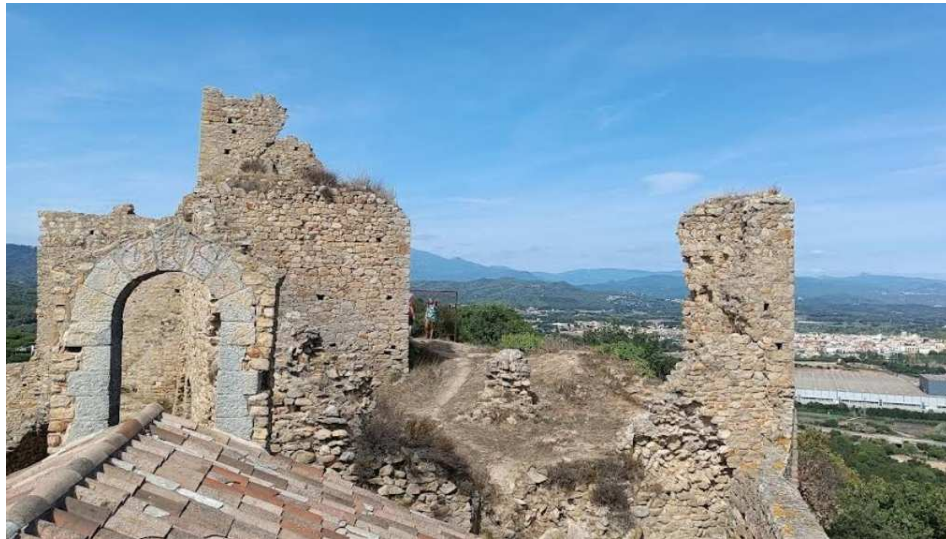
Vista de los restos de la Muralla Norte y muro 17
