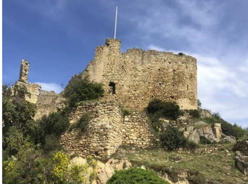
Vista de la Muralla Sureste desde el exterior
