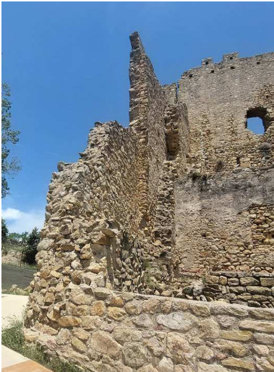
Estado actual del extremo sur de la Muralla Oeste
