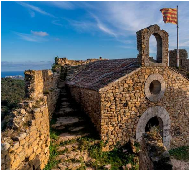
Vista de la Muralla Noreste (Muros 5 y 6)
