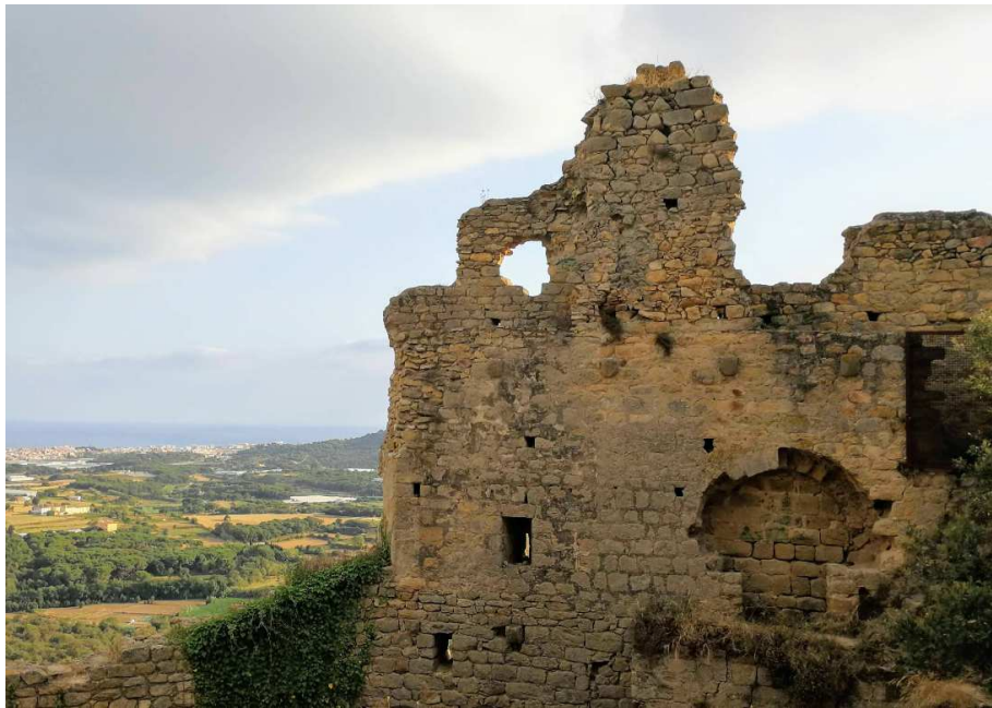
Vista desde el interior del muro 2 y 3
