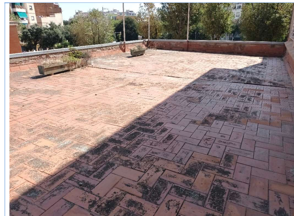
Vista general de la coberta
