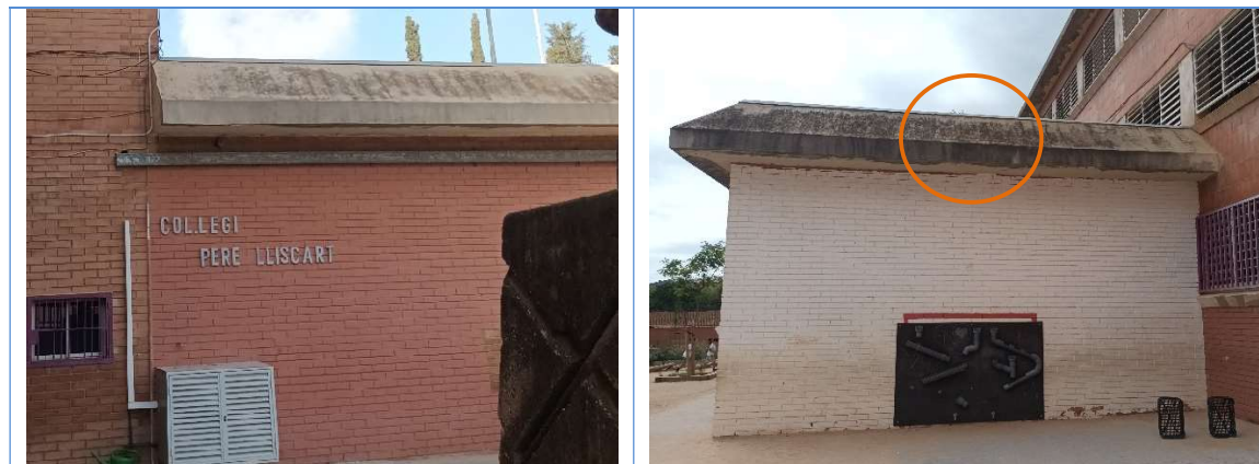
Vistes de la coberta objecte de inspecció, i detall del l'element que constitueix l'aler o ràfec.
