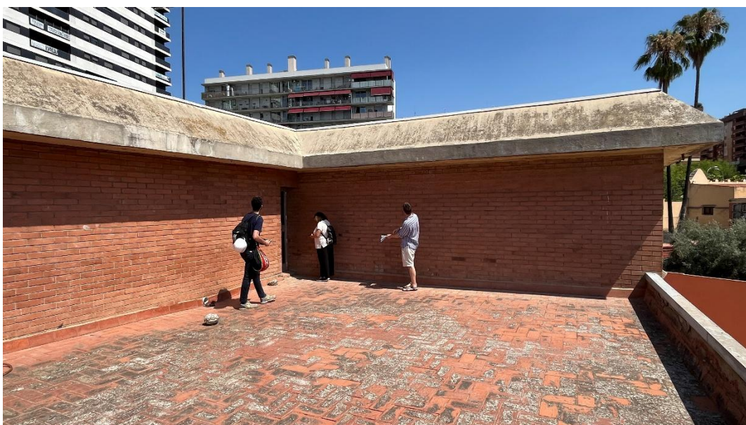
TERRASSA DE P3 (COSTAT EST) DESTINADA A L'AMPLIACIÓ DE L'AULA 1.2.
