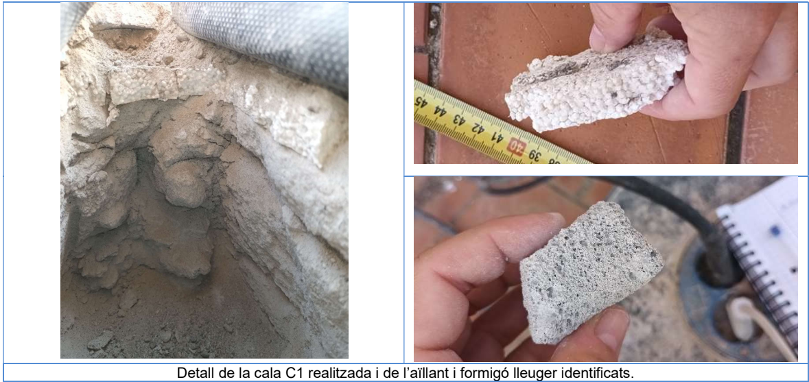
Detall de la cala C1 realitzada i de l'aïllant i formigó lleuger identificats.
