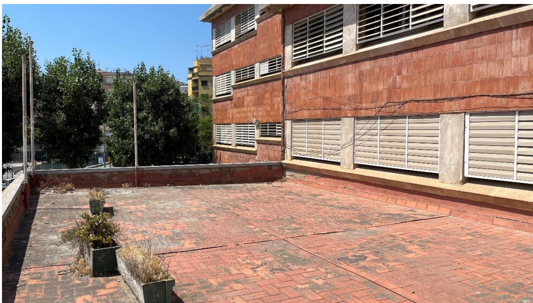
TERRASSA DE P2 DESTINADA A LA NOVA AULA DE SIEI
