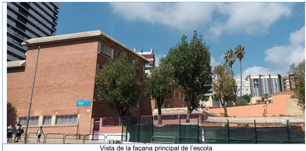
Vista de la façana principal de l'escola
