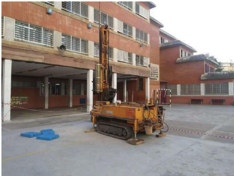
Emplaçament i màquina utilitzada en sondeig S-02.
