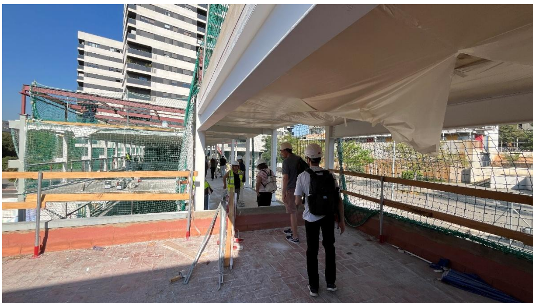
PASSADIS DE TROBADA ENTRE L'EDIFICI VELL I EL NOU EN TERRASSA DE P3.
