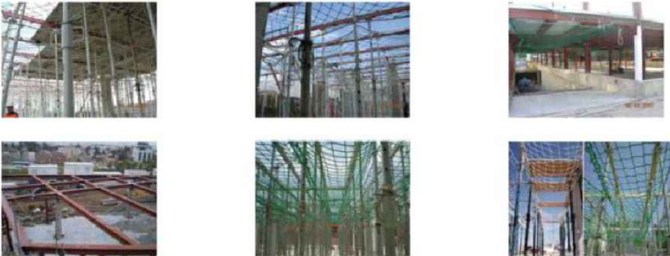
EXEMPLE DE MUNTATGE DE XARXA REUTILITZABLE AMB GANXO
