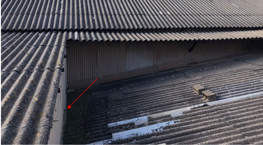
Ubicació de la canal pluvial de pvc a reparar.
