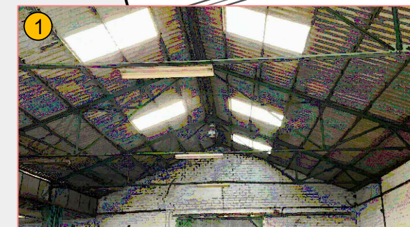
14_Retirat total de planxes ondulades de fibrociment existents, tipus uralita. NAU 1 i 2
