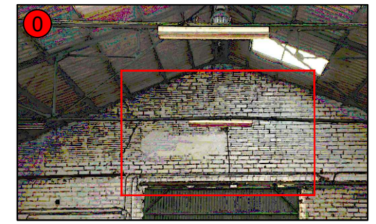
0_ Enderroc de façana. Nova construcció amb maó foradat 275*125*93 tipus "Gero", i pintat de blanc NAU 1
