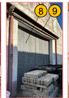
12_Retirat de baixants i canal pluvial existents de fibrociment - NAU 1
