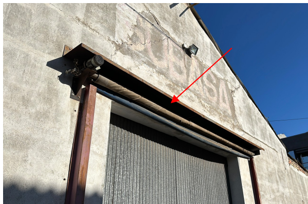
Inclou retirada de porta enrotllable existent.
