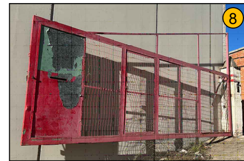
8_Retirada de portes existents. NAU 2 La porta exterior que tènca el pati es repara i munta de nou.
