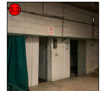
5.3_ Tapat de la part inferior del forat d'obra, per a convertir l'obertura en una finestra - NAU 1
