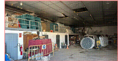
1.1_Retirada de plaques de cel ras existent, malmeses. NAU 2
