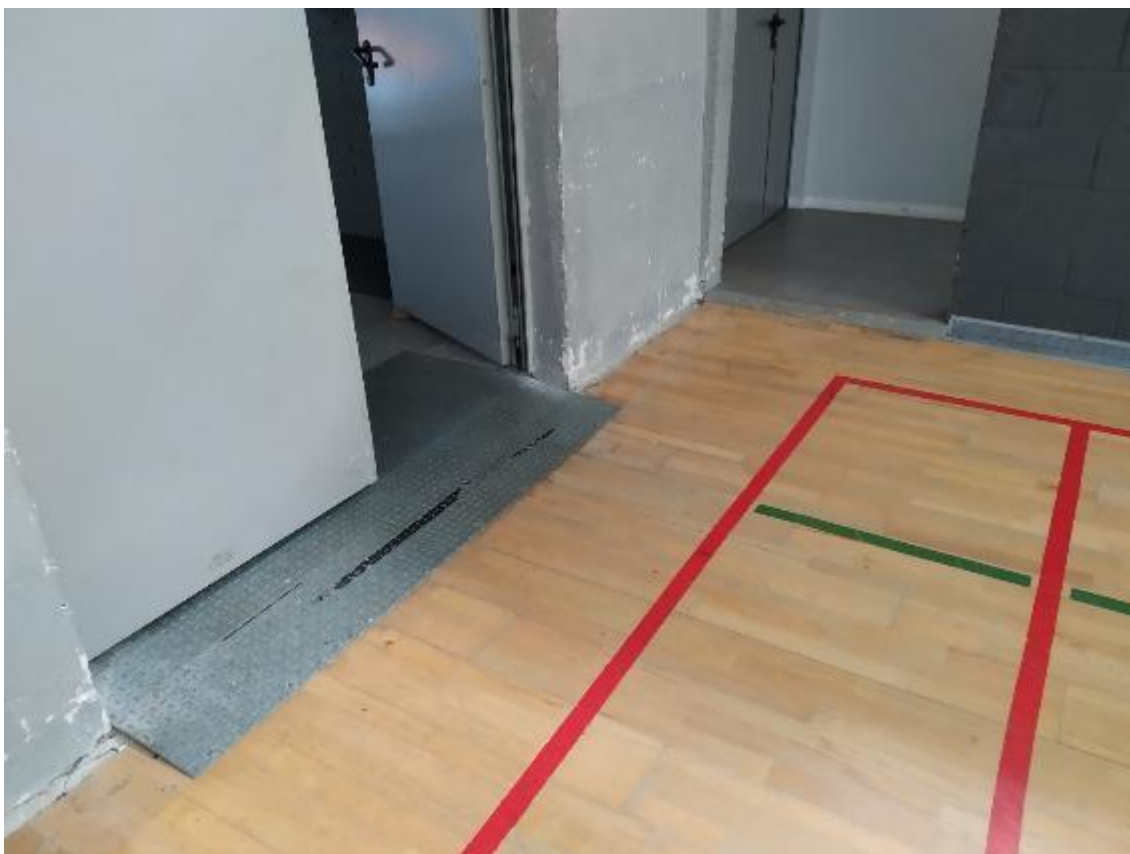
Xapa per salvar el desnivell existent entre els accessos a la pista i la pista.
