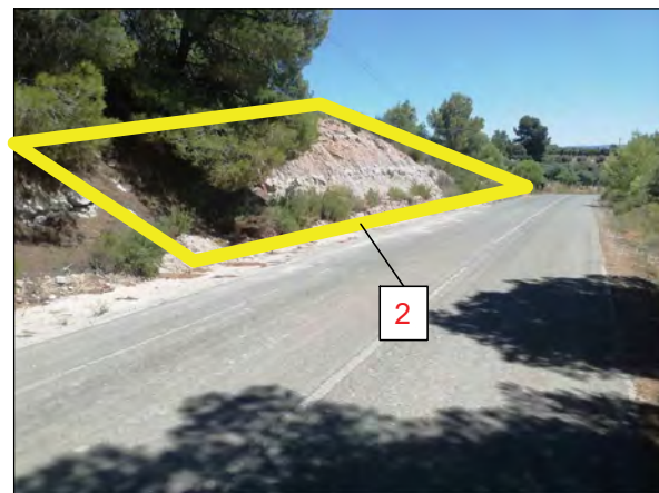
Tram 1 (àmbit aproximat imatge)
