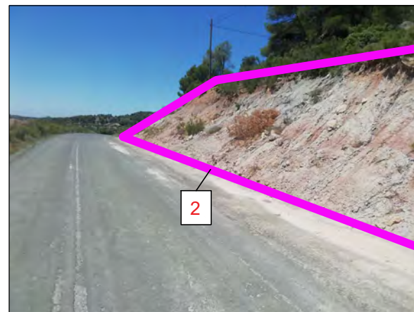
Tram 3 (àmbit aproximat imatge)
