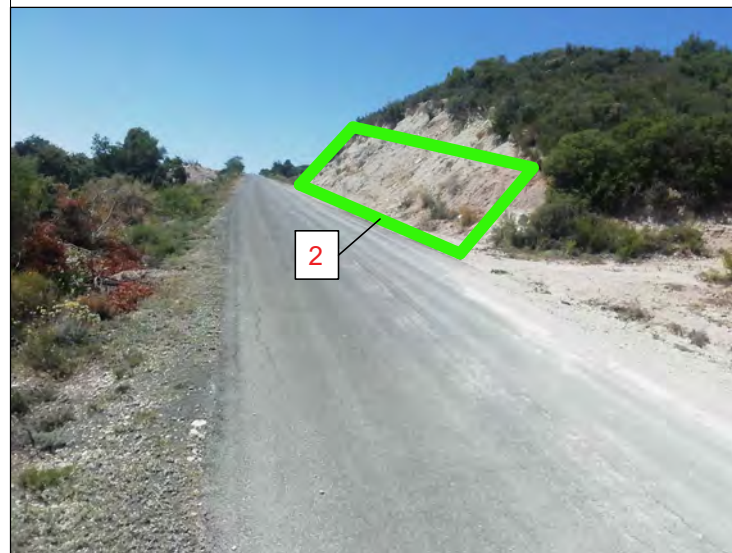
Tram 5 (àmbit aproximat imatge)
