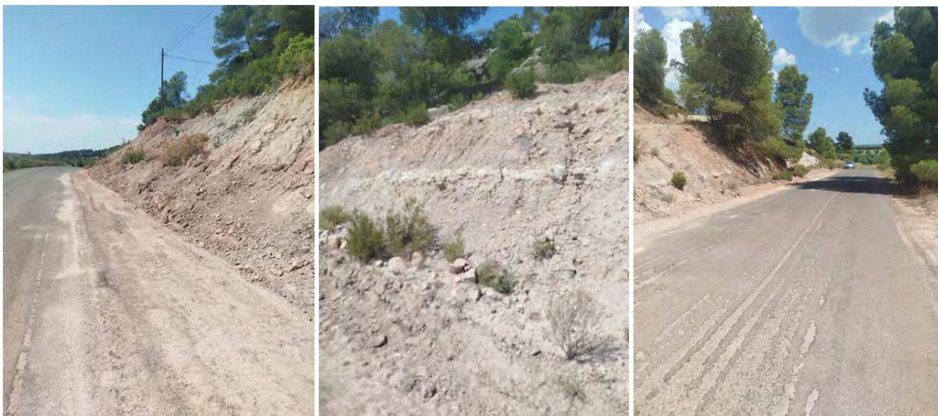
Imatges de la pista a Casteldans, dins al TM de Cervià de les Garrigues, en les zones dels talussos
