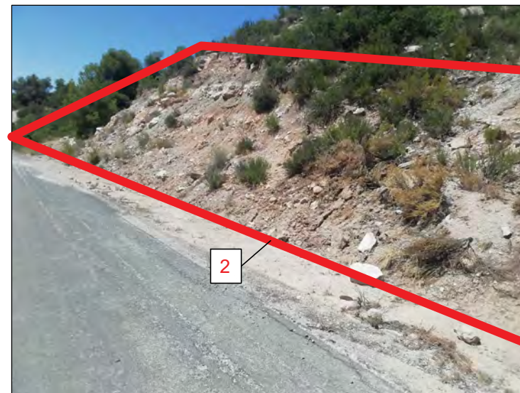
Tram 4 (àmbit aproximat imatge)
