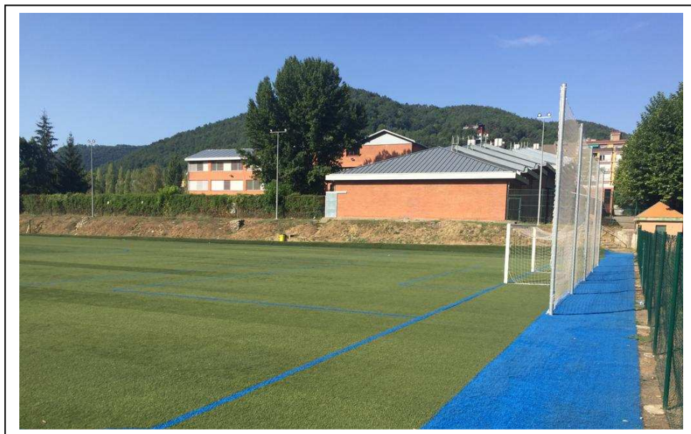
Imatge 3. Vista General camp de futbol II
