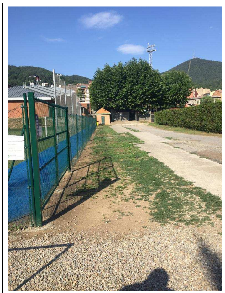
Imatge 4. Vista futur traçat canalització soterrada enllumenat torres camp futbol II
