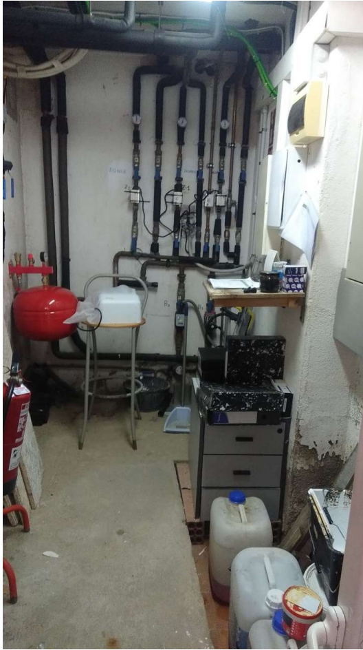
Bomba recirculació calefacció vestidors
