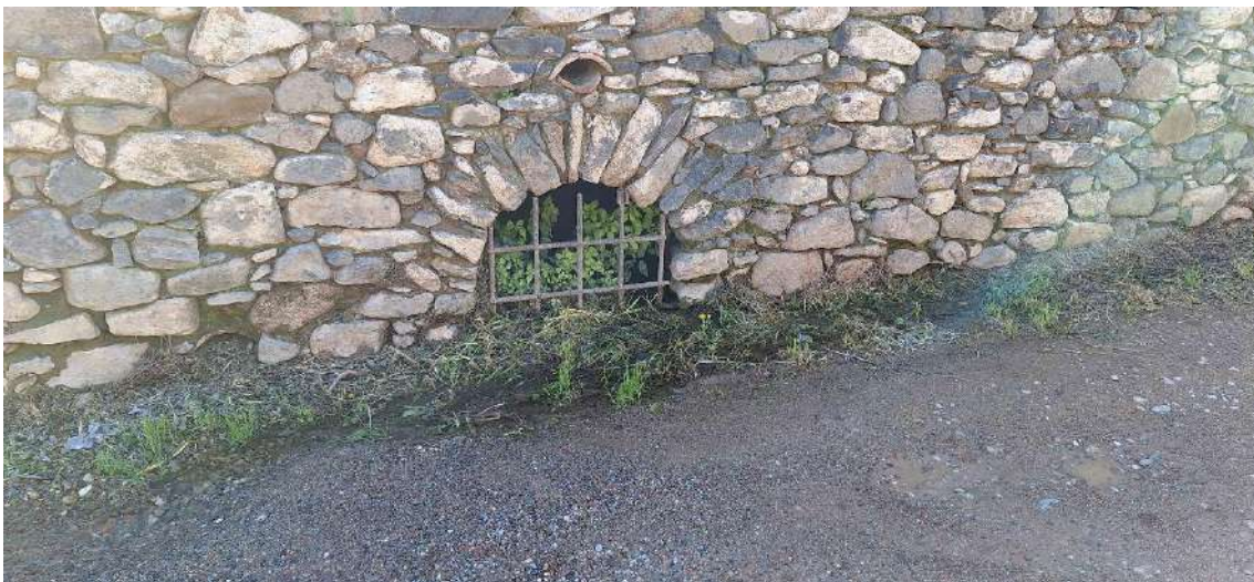
Fotografia 3 i 4_ Mina d'aigua existent.
