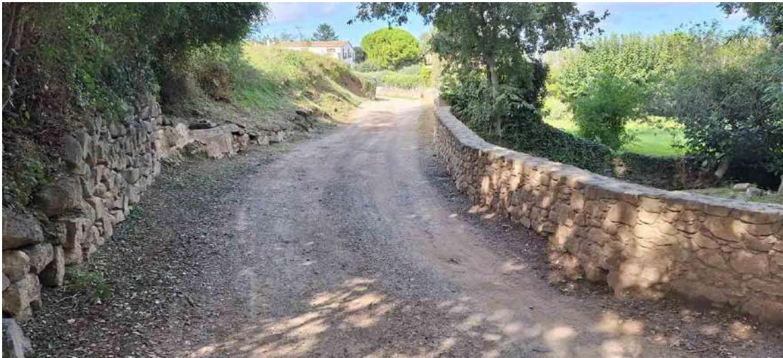
Fotografia 5_Camí de Sobrevila, zona de la font, vista cap a nord.
