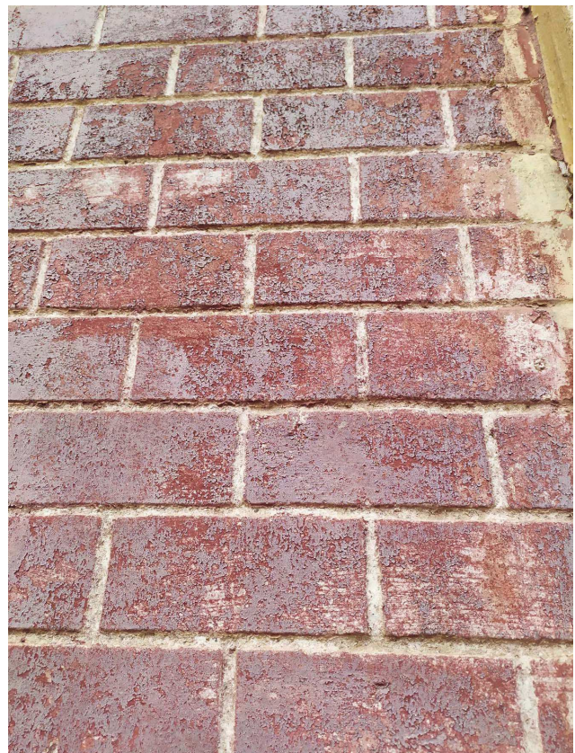
Imatge d'estuc imitació totxo amb antigrafiti deteriorat.
