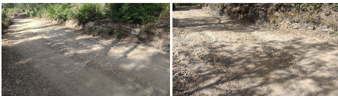
Figura 4. Fotografies de l'estat actual dels trams susceptibles de ser formigonats.
