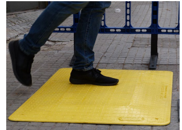
Imatge 2. Mostra de col·locació de planxa de fibra de vidre amb reforç de barres metàl·liques.
