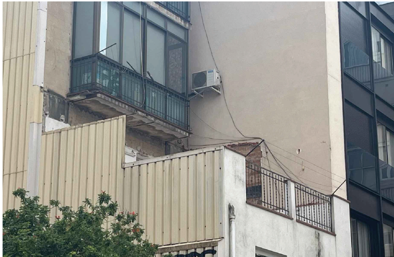
ESTAT ACTUAL FOTOGRAFIES 02
