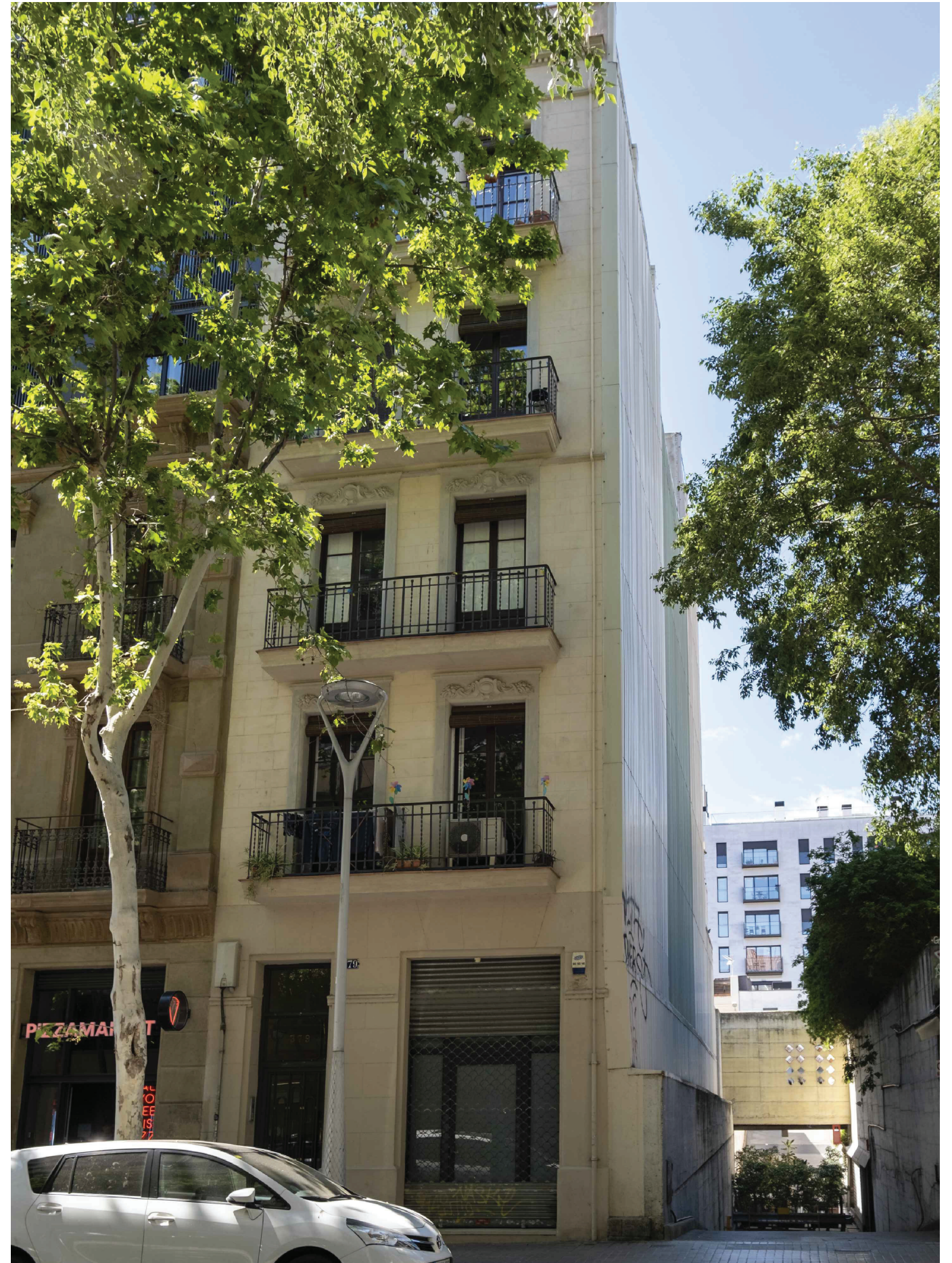
ESTAT ACTUAL FOTOGRAFIES 03
