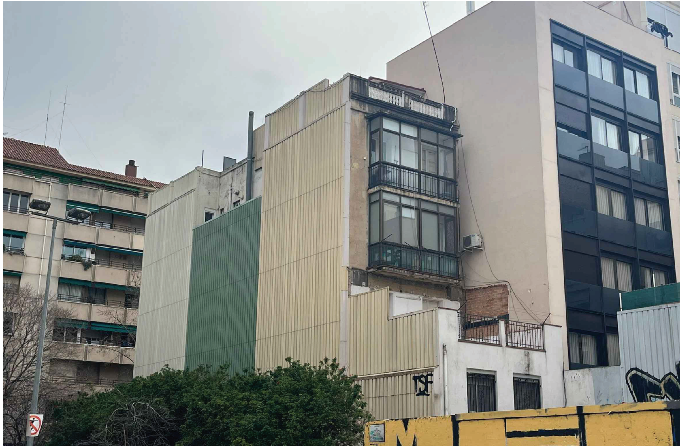
ESTAT ACTUAL FOTOGRAFIES 01
