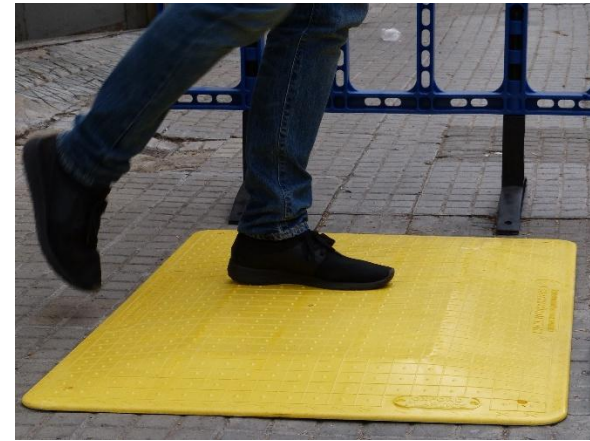
Imatge 2. Mostra de col·locació de planxa de fibra de vidre amb reforç de barres metàl·liques.
