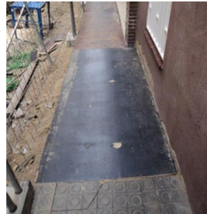
Imatge 1. Mostra de col·locació de planxa de protecció en rasa o pou.
