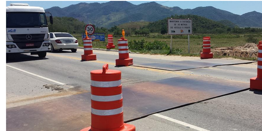
Imatge 3. Mostra de placa de ferro per a cobertura de rases apta per al pas de vehicles.
