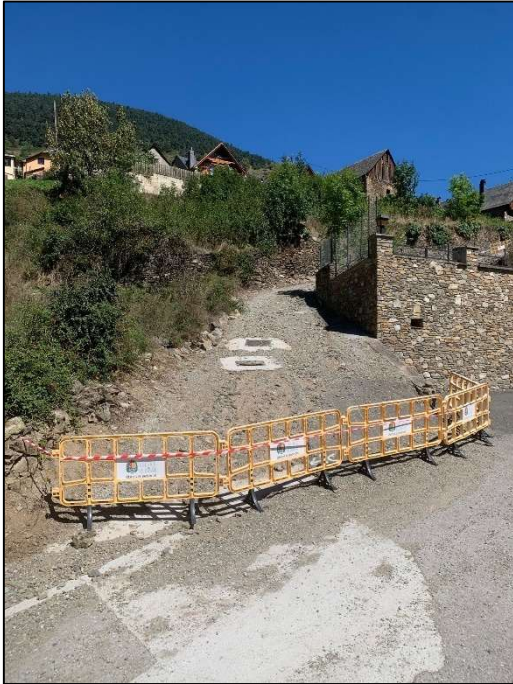
Ilustración 4: Acceso inferior Calle Costa
