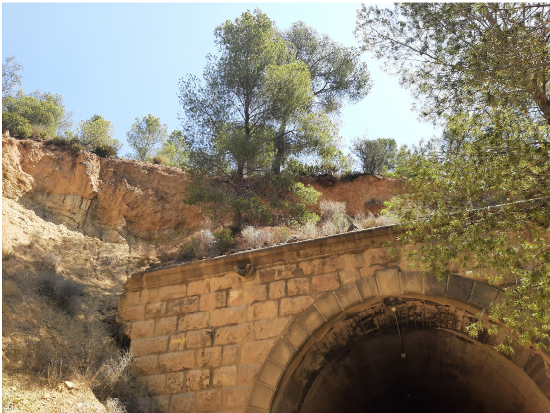
Imatge 2. Boca sud de túnel H. Parament frontal de carreus i perímetre del brocal format per carreus de pedra regular. Descalçat.
