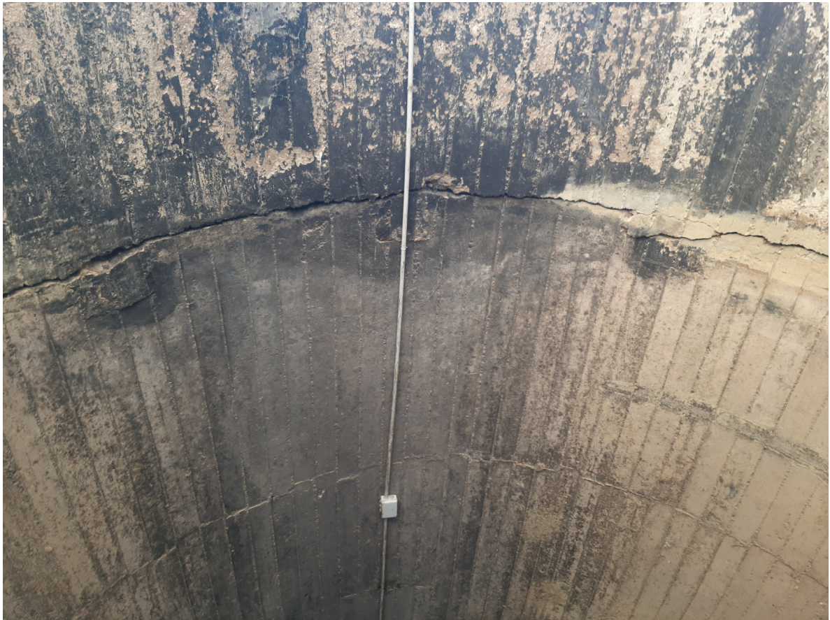
Imatge 3 i 4. Boca Nord de túnel H. Esquerda a secció completa
