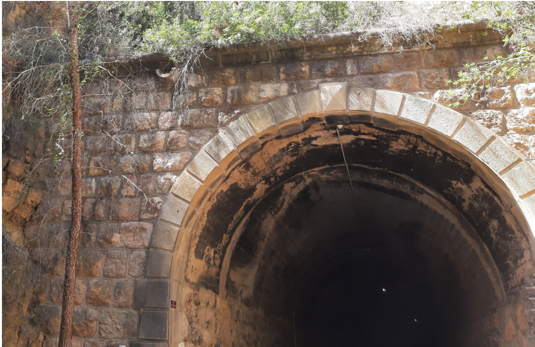
Imatge 1. Boca Nord. Morfologia de túnel en U amb un revestiment de volta de formigó encofrat i murs rectes de pedra de carreus irregulars.
