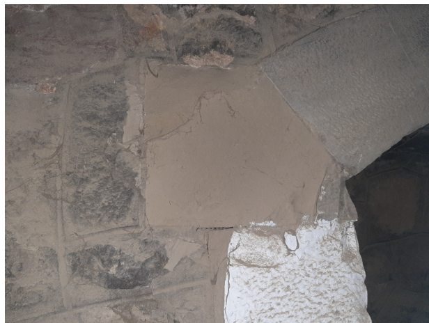
Imatge 24. Reparació de carreu perdut en apartador
