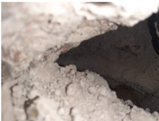
Imatge 27. Manca de carreu que permet estimar el gruix total del mur
