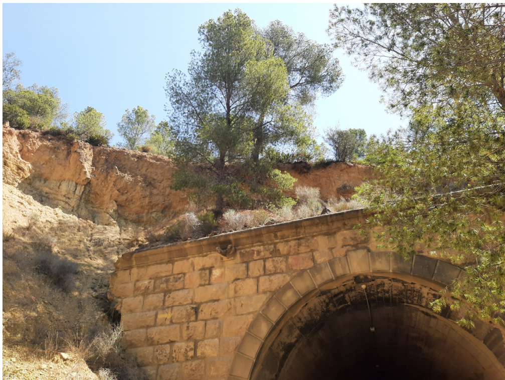
Imatge 4. Boca sud de túnel H. Parament frontal de carreus i perímetre del brocal format per carreus de pedra regular.
