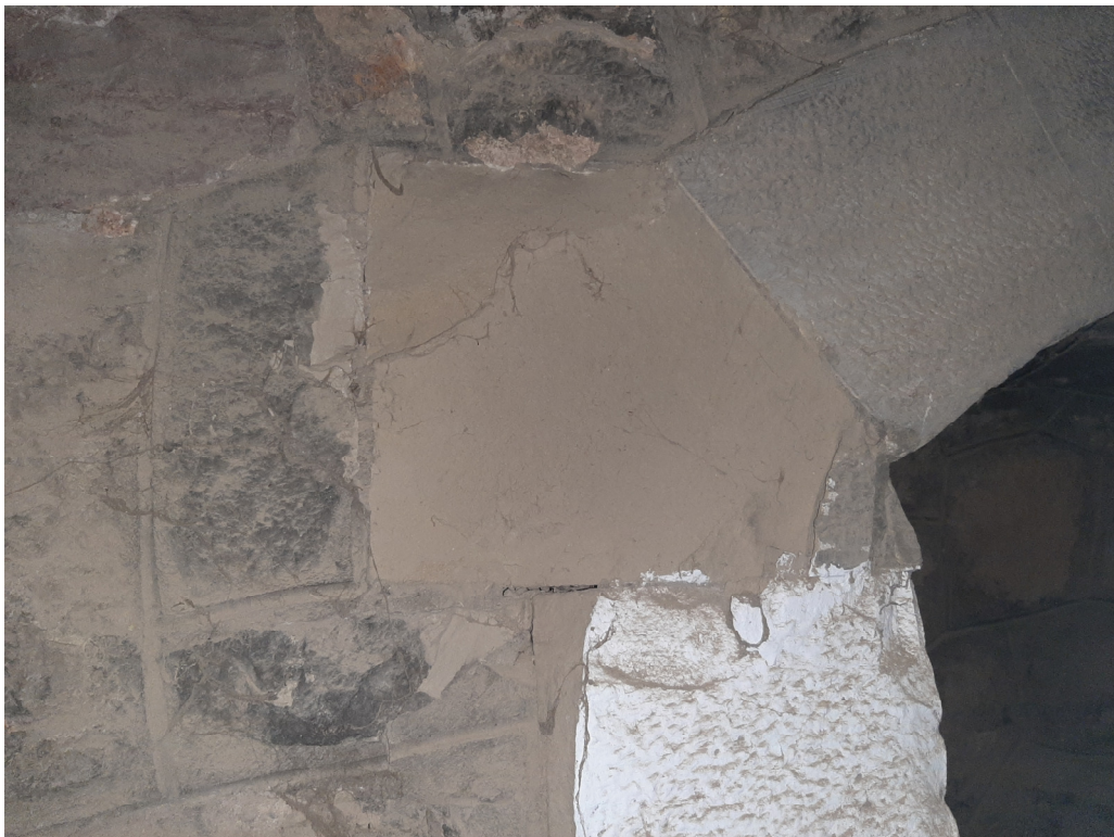
Imatge 22. Reparació de carreu perdut en apartador
