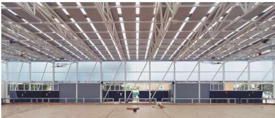
Vista interior façana sud
