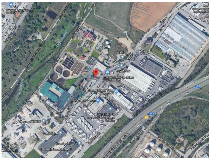
Figura 1. Vista aèria del CCTRVO (Font: Google Maps 2019)
