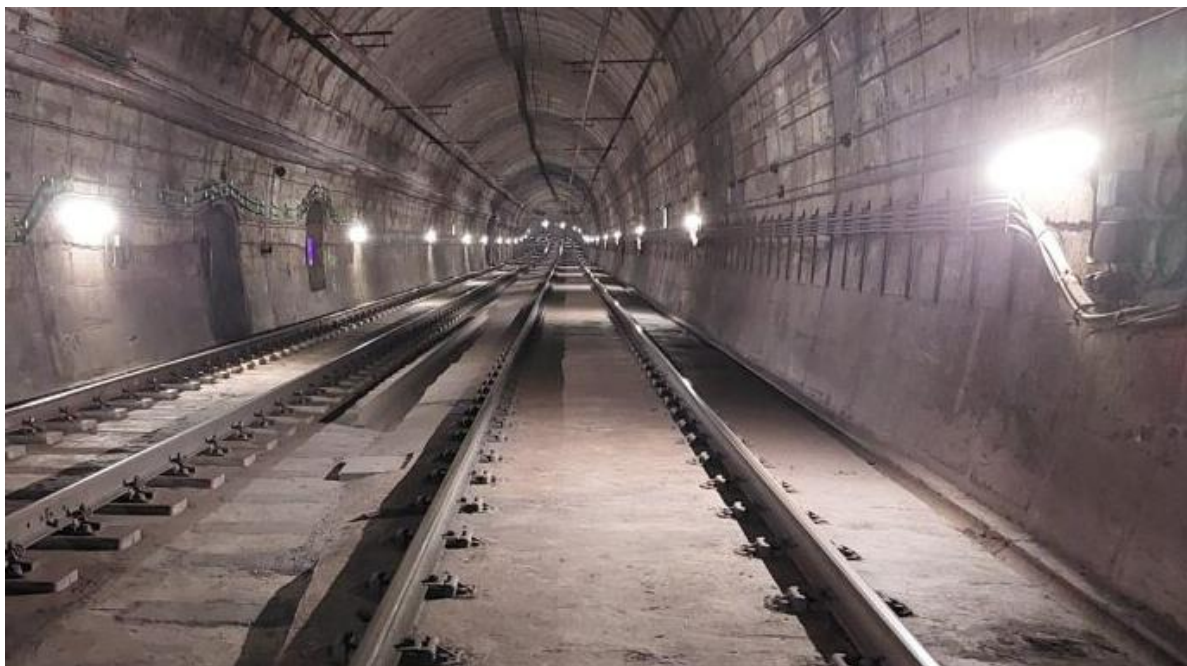
Imatge 3. Imatge del tram de superestructura de via a renovar. Font: F.M.B.
