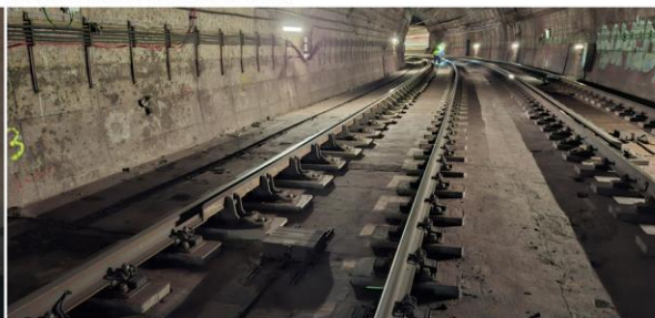
Vista costat SANTA COLOMA inici actuació
