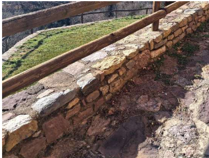
Imatge 15. Mur existent consolidat amb morter que sosté un tram de barana de fusta a Sellui en bon estat.
