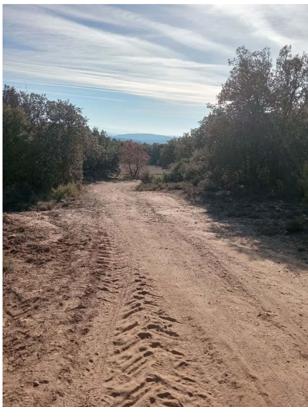
Pk 4,2. Forta pendent
