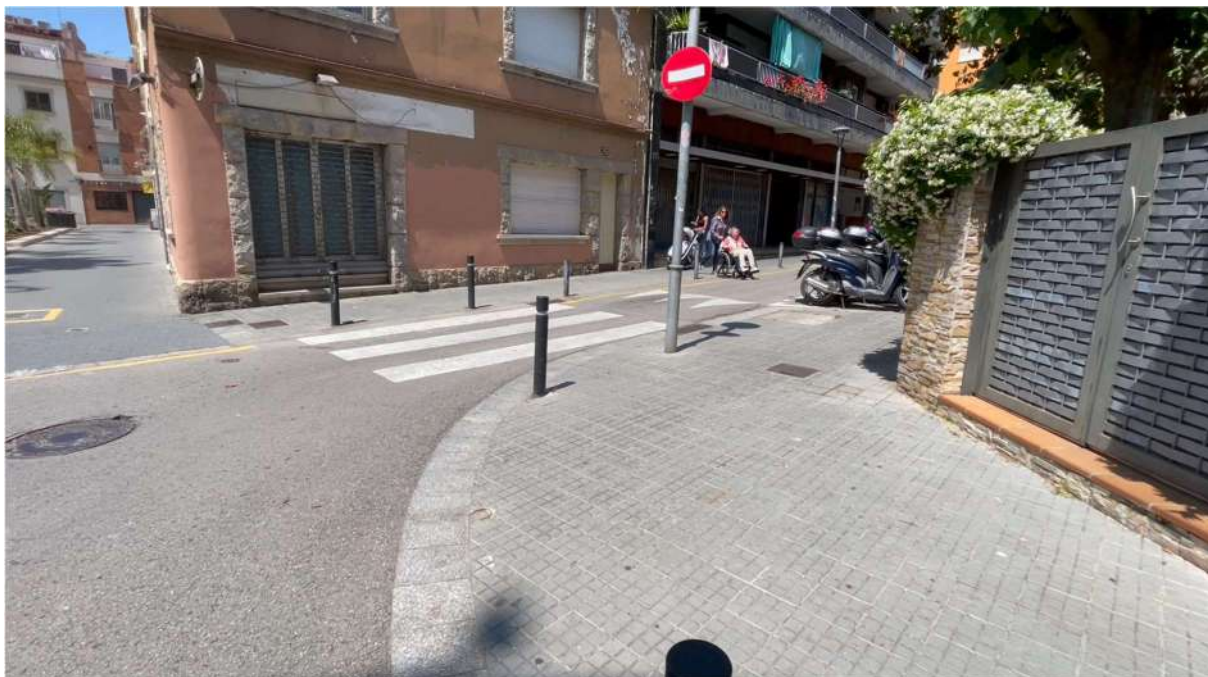
Punt d'inici de les obres
