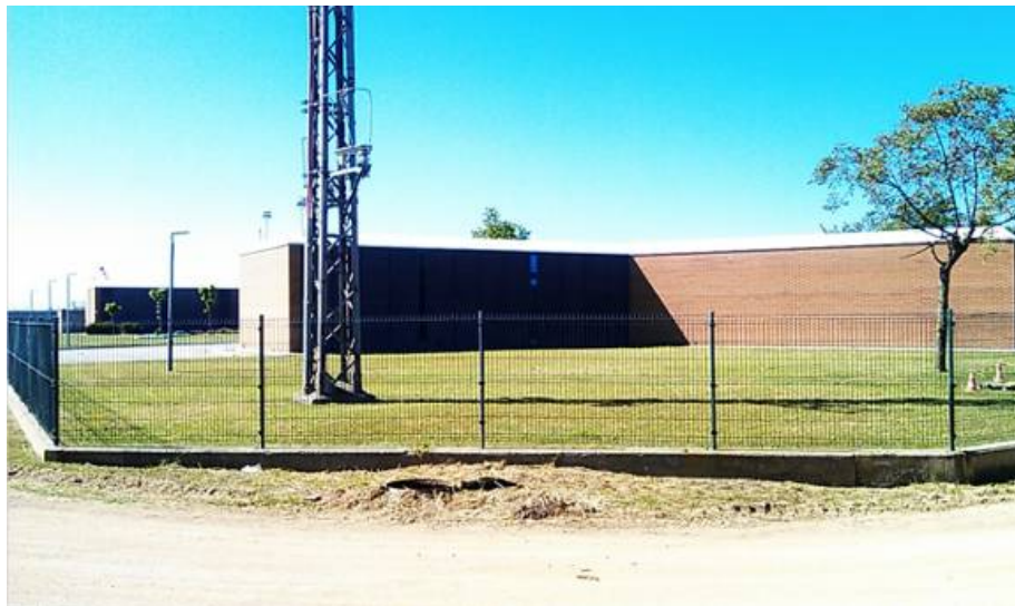
Ubicació vàlvula d'aïllament
