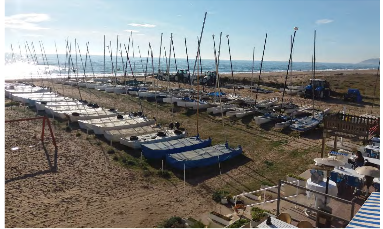
Fotografía 7. Vista de la zona de varada des de la planta primera del edificio del Club (lado poniente)
