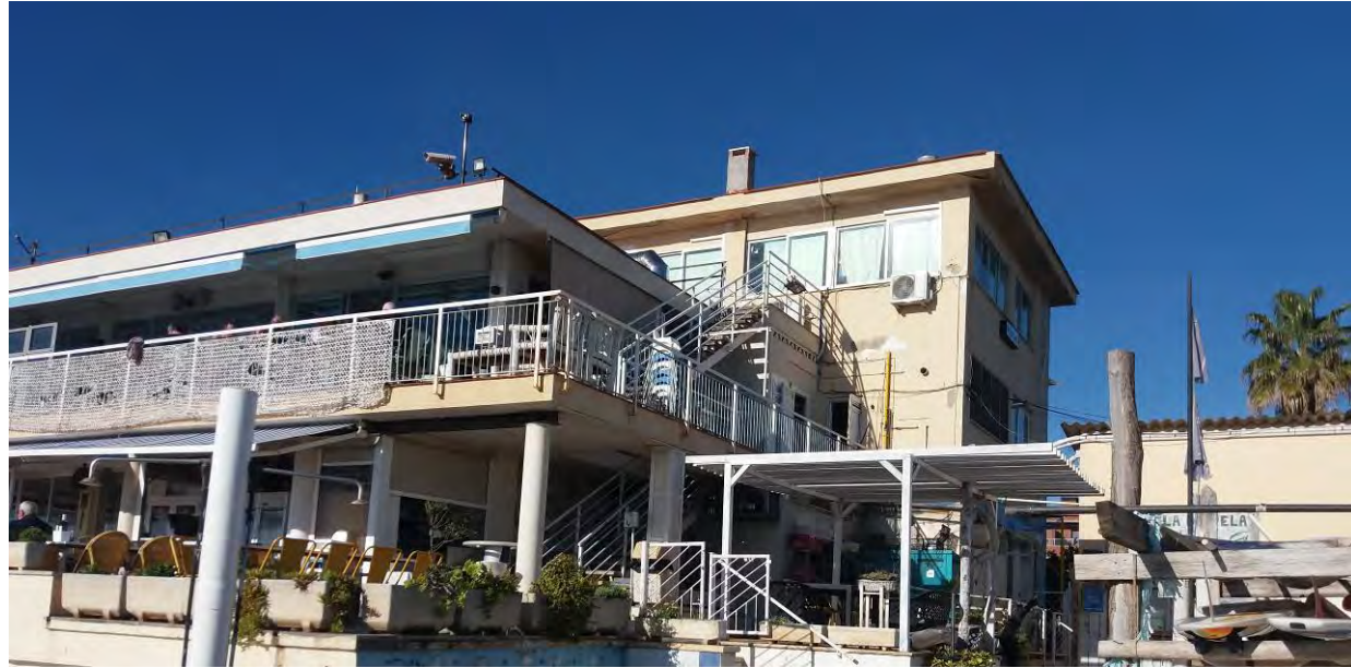
Fotografía 9. Vista del edificio desde la zona de varada.
