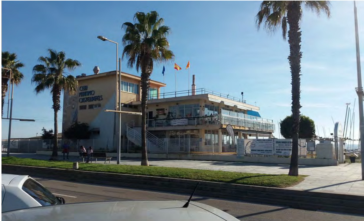
Fotografía 1. Vista del edificio del Club, desde el Paseo Marítimo de Castelldefels
