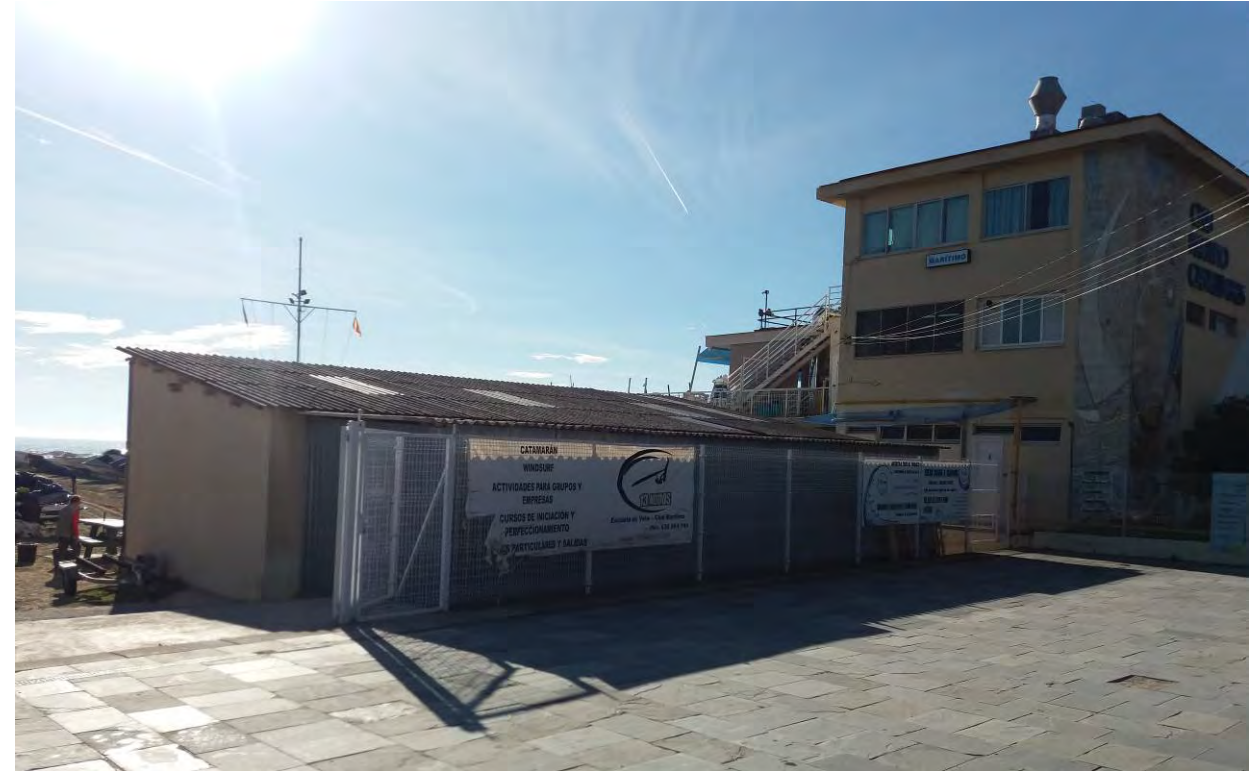
Fotografía 3. Edificación auxiliar existente a levante. El presente proyecto contempla su demolición.
