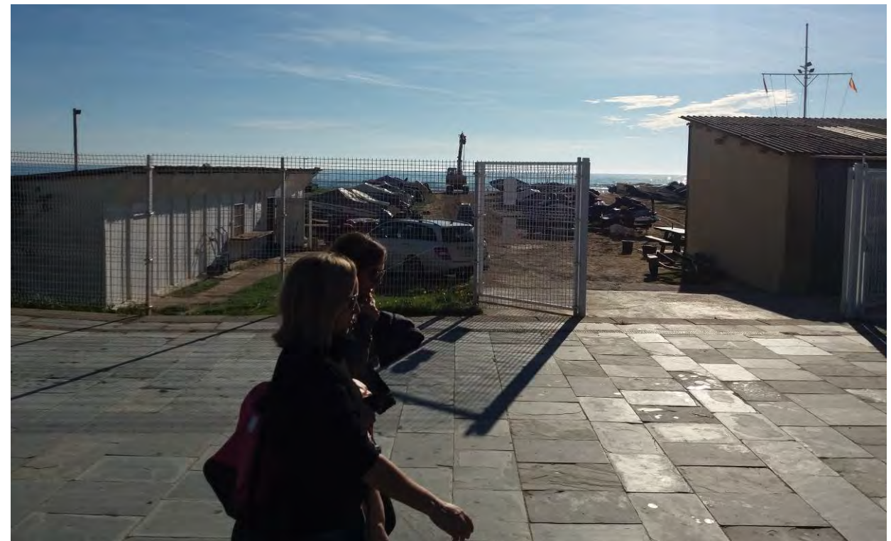
Fotografía 4. Edificación auxiliar existente a levante. El presente proyecto contempla su demolición.
