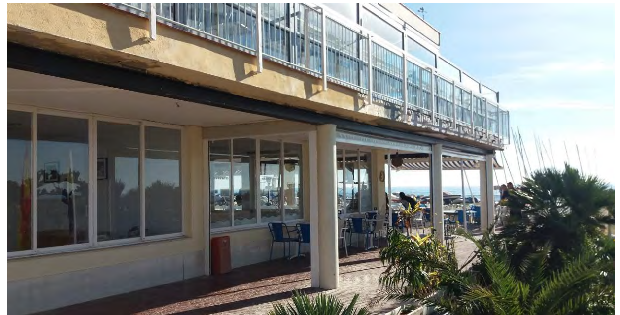
Fotografía 8. Fachada de poniente del edificio del club, con refuerzo de voladizo mediante pórtico metálico.
