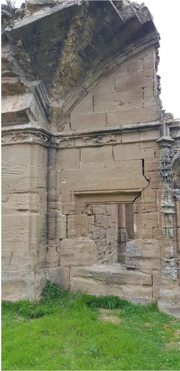
Ventana muro Oeste Capilla
