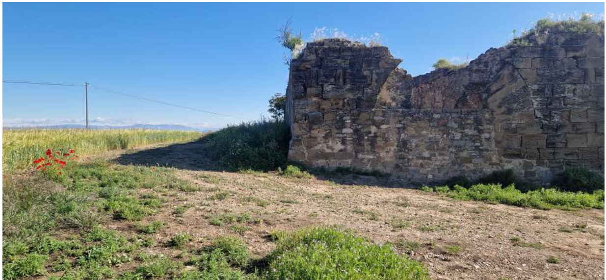
Fachada principal, parte izquierda.
