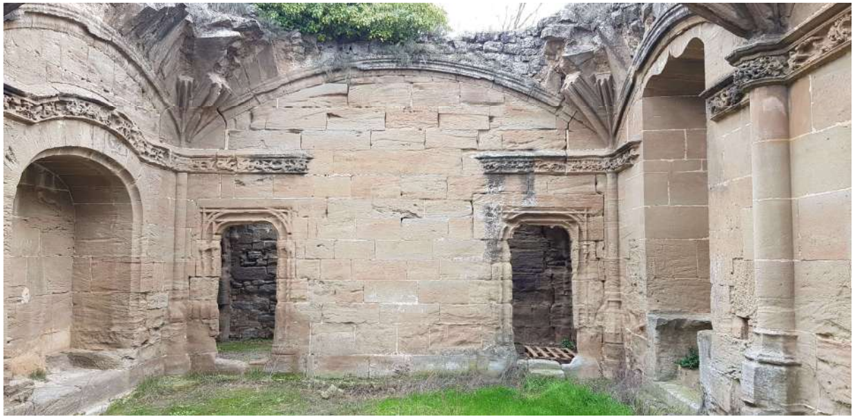
Capilla, muro Este
