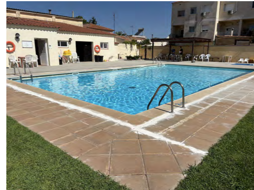
INTERVENCIÓ EN PISCINA MUNICIPAL
